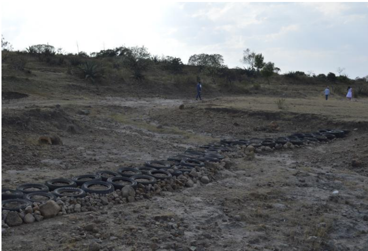
Figura 2. Vista frontal de represa de llantas para el control de cárcavas (San Antonio Segundo Cuartel).
