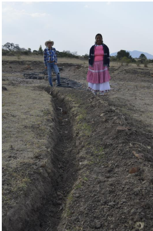
Figura 12. Zanja para generación de terraza de formación sucesiva asociada a presa de llantas (San Antonio Segundo Cuartel).
