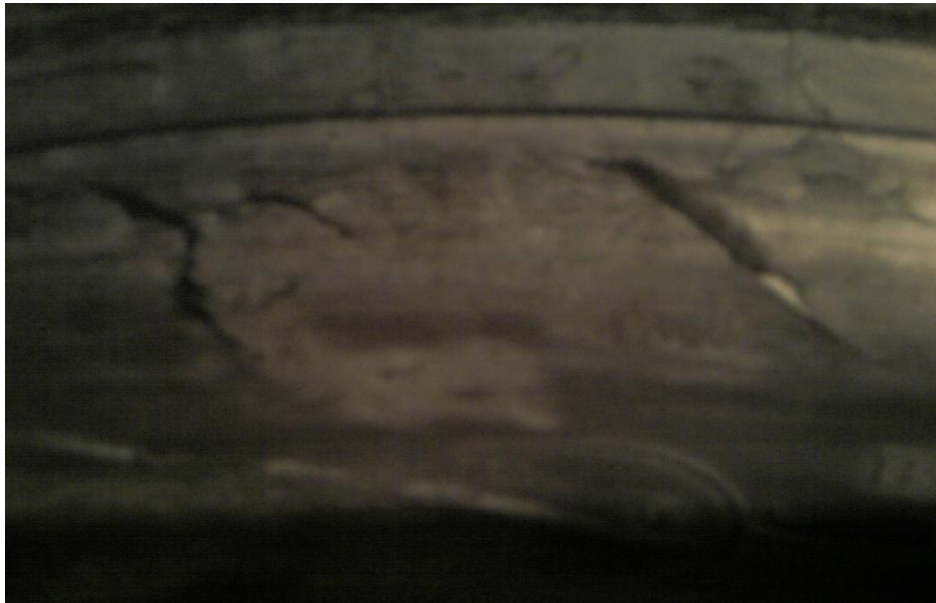
Figura 3.14 Agrietamiento diagonal
