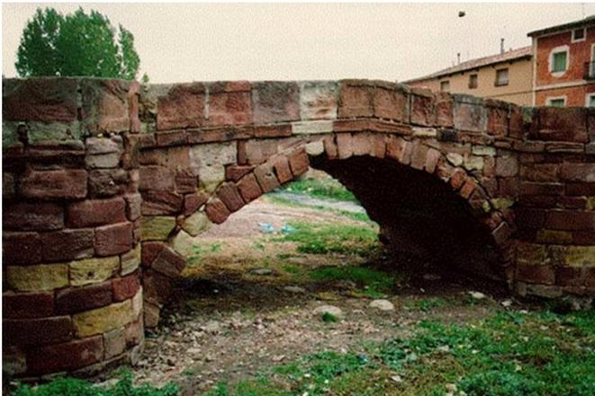
Figura 82. ALT-04 Descripción: Desagregación (Arenización/Pulverización/Descohesión). Obtenida de ((CEDEX), 2013).
