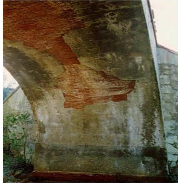
**Figura 104. FUN-04 Descripción: Desprendimiento del revestimiento. Obtenido de ((CEDEX), 2013)**
