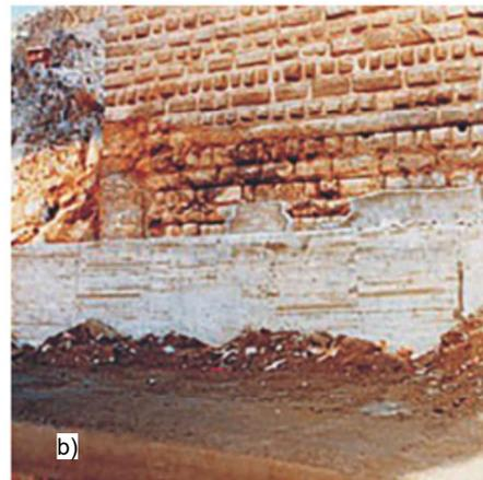
b) Se muestra la reparación de la pila 2 realizada con concreto.
