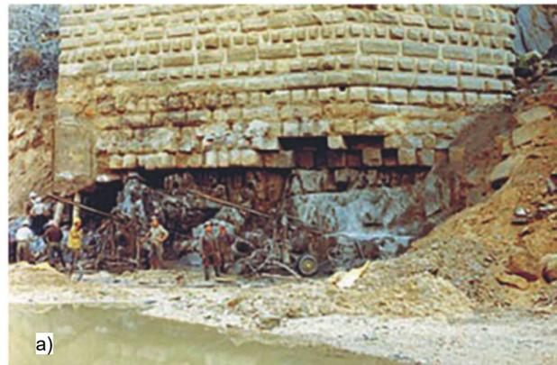
a) Se muestra la socavación en la pila 2 vista en perspectiva.
