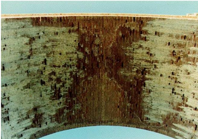
**Figura 101. FUN-05 Descripción: Manchas de humedad e inadecuado funcionamiento de los mecinales. Obtenido de ((CEDEX), 2013)**
