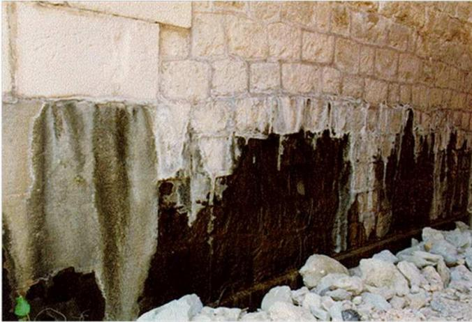
Figura 77. ALT-02 Descripción: Depósitos salinos (Eflorescencias/Concreciones/Incrustaciones/Costras Negras). Obtenida de ((CEDEX), 2013).
