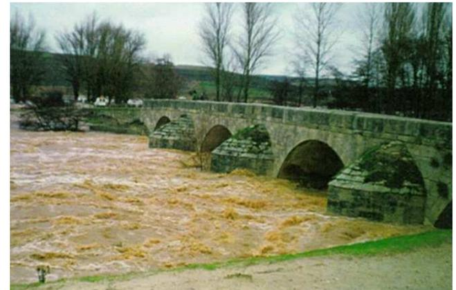
Figura 96. FUN-02 Descripción: Disminución de la capacidad de desagüe bajo el puente. Obtenido de ((CEDEX), 2013)
