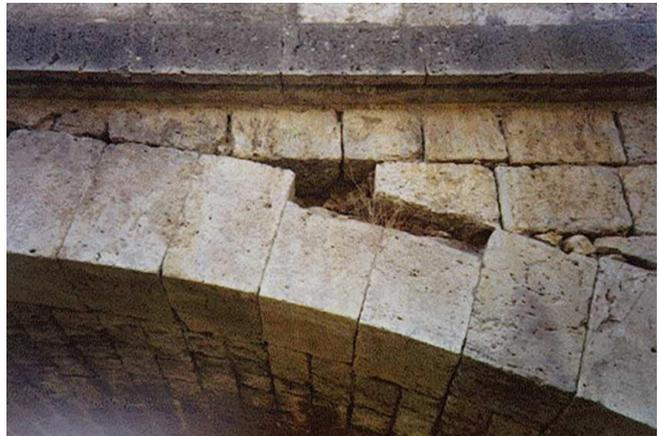
Figura 98. FIS-17 Descripción: Rotura de aristas y esquinas de sillares. Obtenido de ((CEDEX), 2013)
