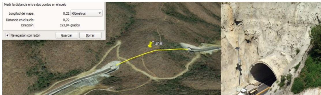
Figura 47. Medición en Google Earth de la distancia real del túnel del caso de estudio (izquierda), e imagen real de este (derecha) donde se aprecia su altura relativa.
