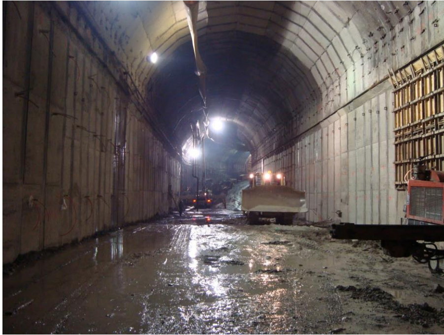
Figura 22. Túnel de desfogue de la presa La Yesca en proceso de construcción.
