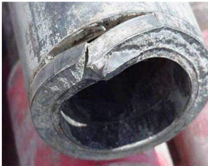
Figura 2.3: Oleoducto con corrosión por H_2S [7].
