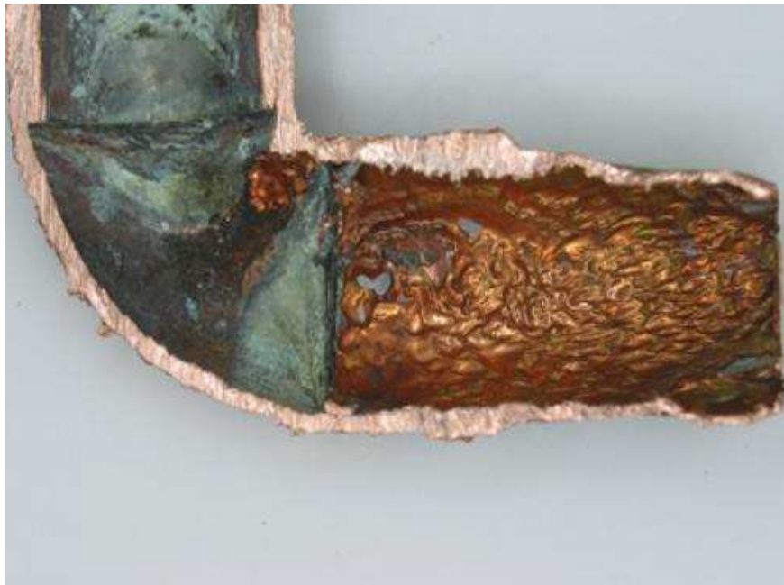
Figura 2.5: Corrosión por Erosión [23].
