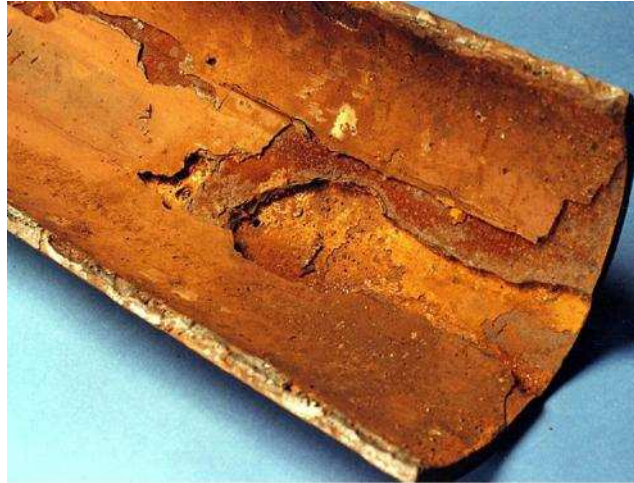
Figura 2.2: Corrosión interna en un oleoducto [7].
