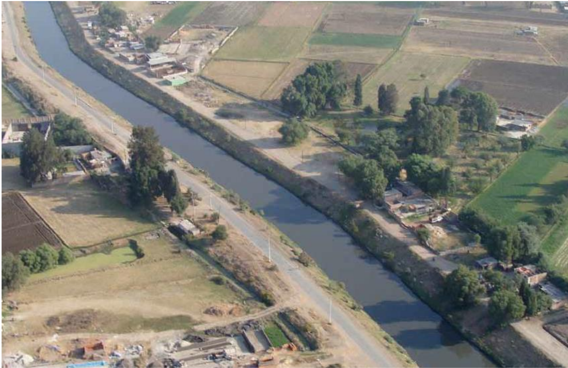
Figura 2.14.- Vista Aérea del Gran Canal de Desagüe
