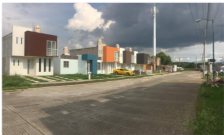
Fig. 37 Panorámica de las viviendas.AVFT
