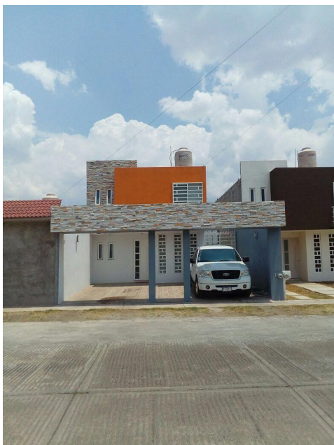
Fig.41 Modificación de fachada principal. AVFT
