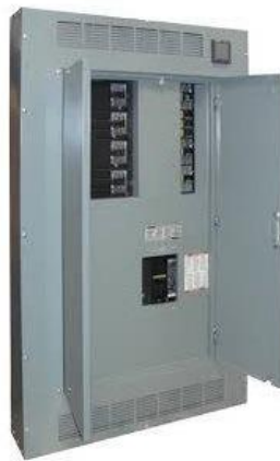
Figura 3.18 Tablero general tipo I LINE con interruptor principal y circuitos trifásicos derivados
