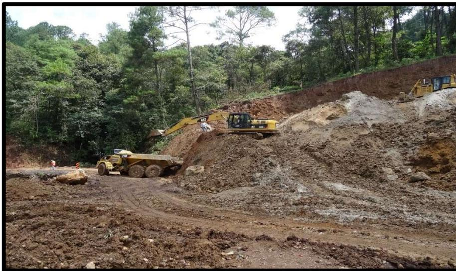
Imagen 5.1.- Excavación en corte, carga y acarreo de material.
