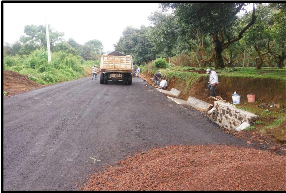
Imagen 5.14.- Construcción de cunetas, antes del tendido de carpeta asfáltica.
