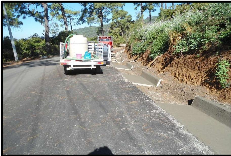
Imagen 5.13.- Construcción de cunetas, después del tendido de carpeta asfáltica.
