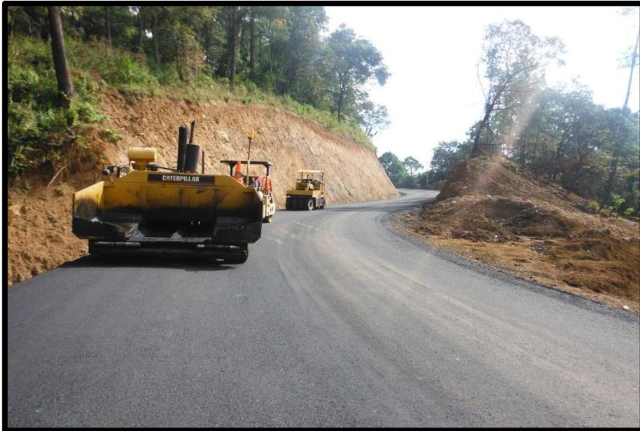
Imagen 5.24.- Equipo utilizado para la construcción de carpeta asfáltica.
