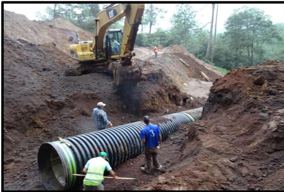
Imagen 5.9.- Relleno de zanja de obra de drenaje con producto de excavación.
