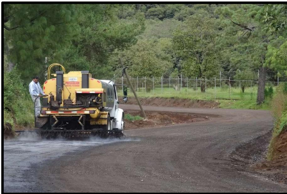
Imagen 5.20.- Petrolizadora aplicando el riego de impregnación.
