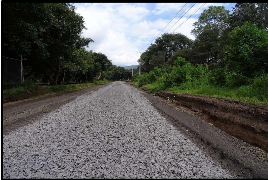
Imagen 5.17.- Base hidráulica ya tendida con la motoconformadora, sin compactar.
