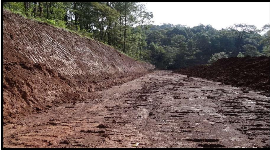
Imagen 5.2.- Excavación de cortes en el km. 3+600.
