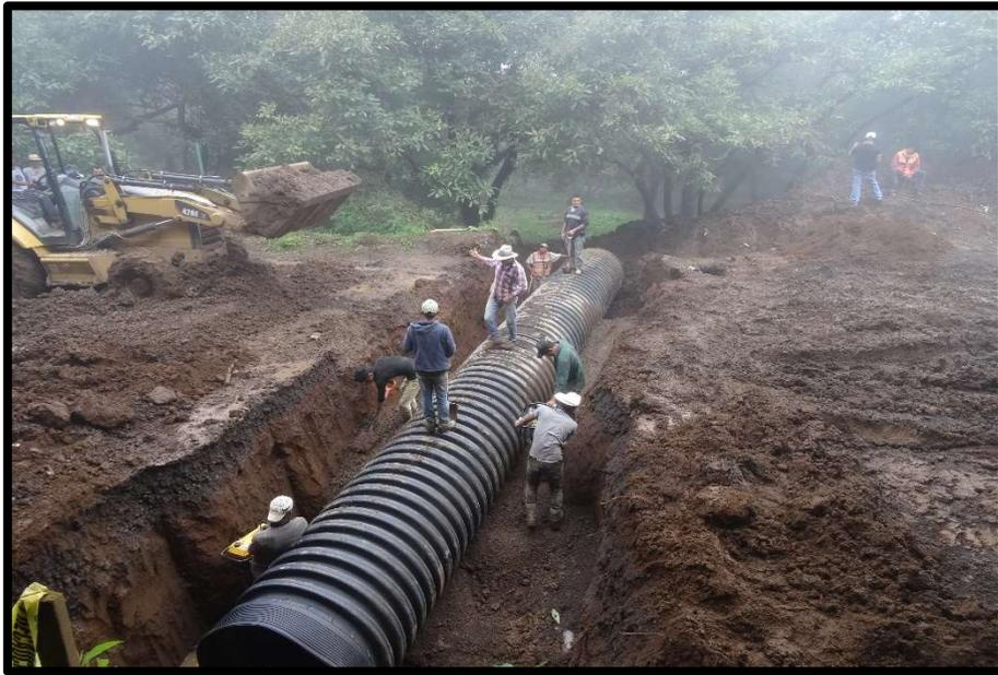
Imagen 5.12.-Colocación de obra de drenaje de tubo de polietileno de alta densidad.
