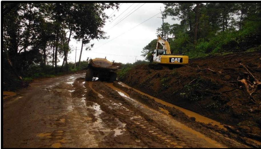
Imagen 5.3.- Excavación de cortes en el km. 3+700.
