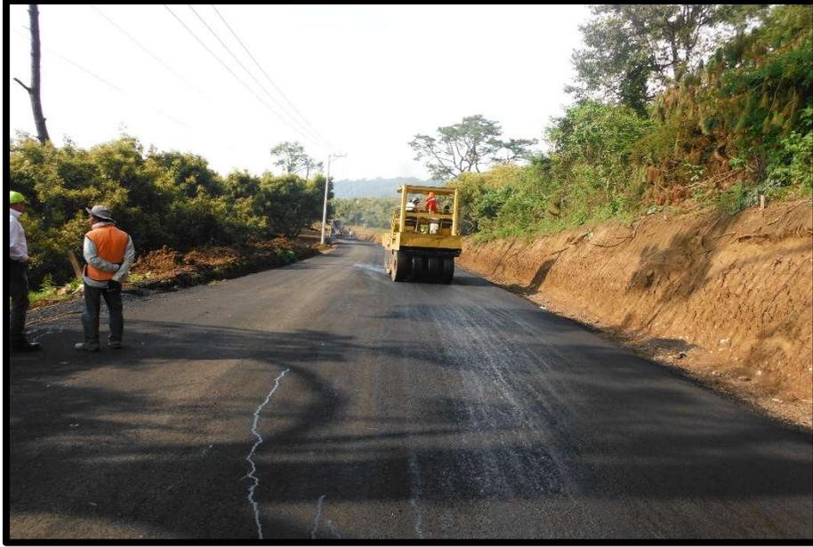
Imagen 5.23.- Compactadora de neumáticos dando el terminado a la carpeta.
