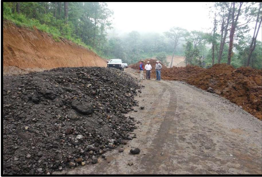
Imagen 5.5.- Material granular acamellonado para la capa filtro km. 3+660.
