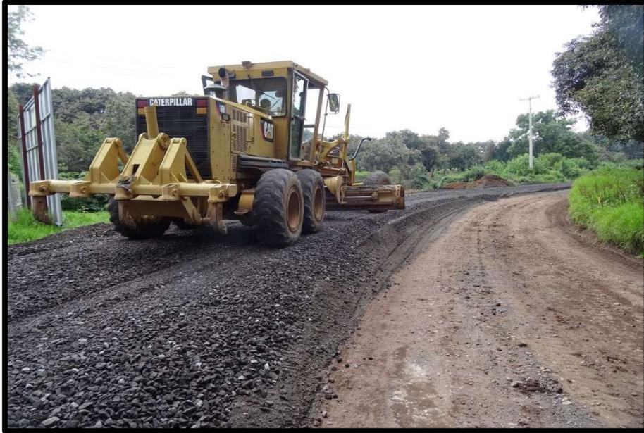
Imagen 5.16.- Motoconformadora tendiendo la base hidráulica.
