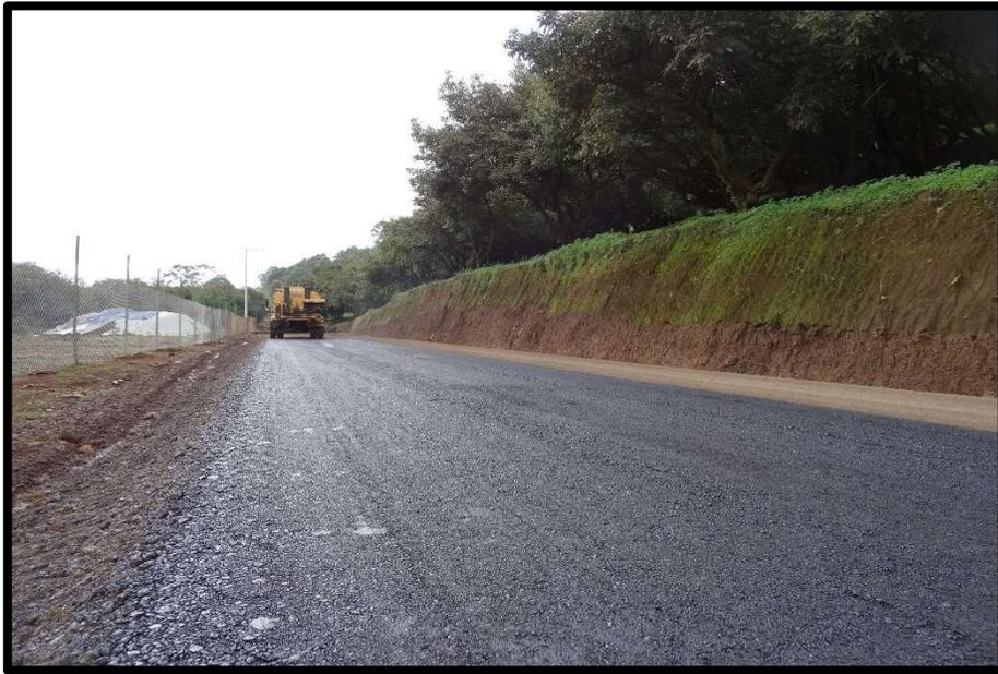
Imagen 5.19.- Petrolizadora aplicando riego de impregnación.
