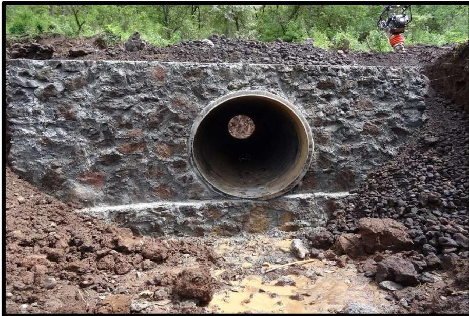
Imagen 5.10.- Estructura de mampostería en obra de drenaje del km. 3+210.
