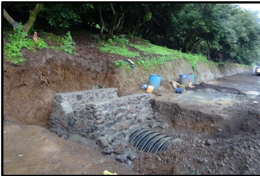
Imagen 5.11. Caja de captación a la entrada de la obra de drenaje en el km. 2+880.
