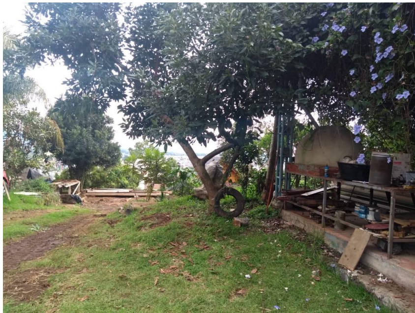
Fotografía 3.3. Existe construcción dentro del predio que será demolida.
