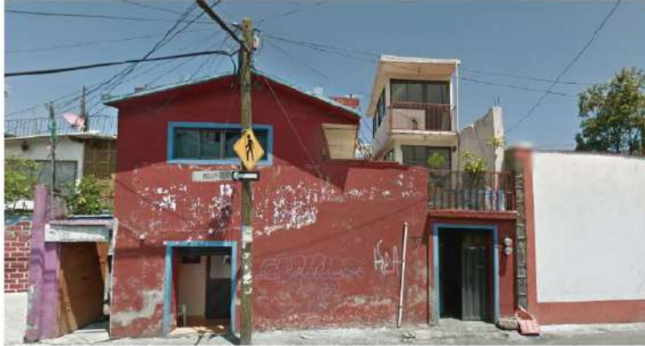
FACHADA SOBRE CALLE INSURGENTES
