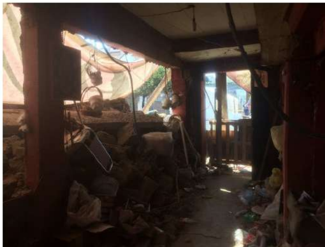
VISTA INTERIOR DE ACCESO
