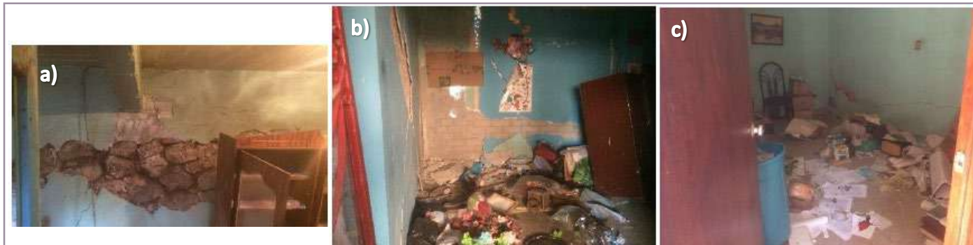
Imag. 21 a) Muro de piedra en PB, expuesto debido a temblor del 19 de Septiembre del 2017. B) Muro de tabique gris en PB. C) Dormitorio en 1° nivel, con desprendimiento de acabados.
