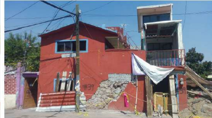
FACHADA SOBRE INSURGENTES
