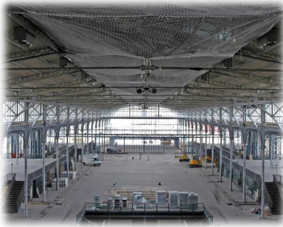
Renovación del interior de Le grande Halle. 2005 -2007. Foto. Jean-Pierre-Delagarde. (@BernardTschumiArchitects, 2018)
