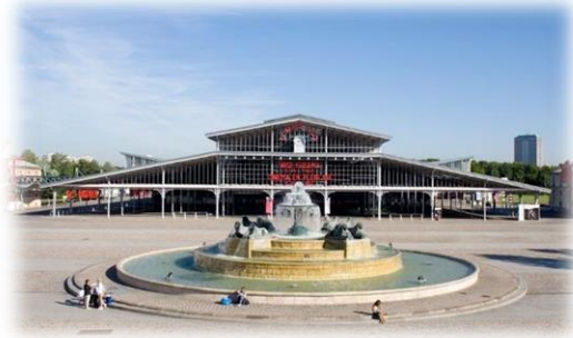
Entrada sur al parque La Grand Halle de La Villette. Sophie Chive. 2008. (EPPV, 2018)
