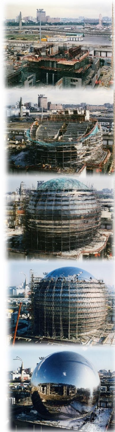
Progreso constructivo de La Géode (EPPV, 2018).
