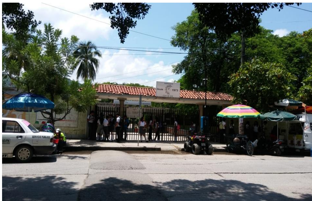
Fachada del Centro de Bachillerato Tecnológico, industrial y de servicios No. 56
