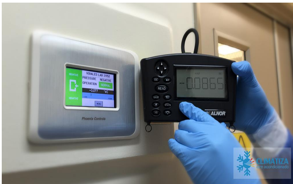
Figura 9. Muestra la medición de presiones diferenciales de un área a otra del BSL-3, utilizando un multímetro calibrado.
