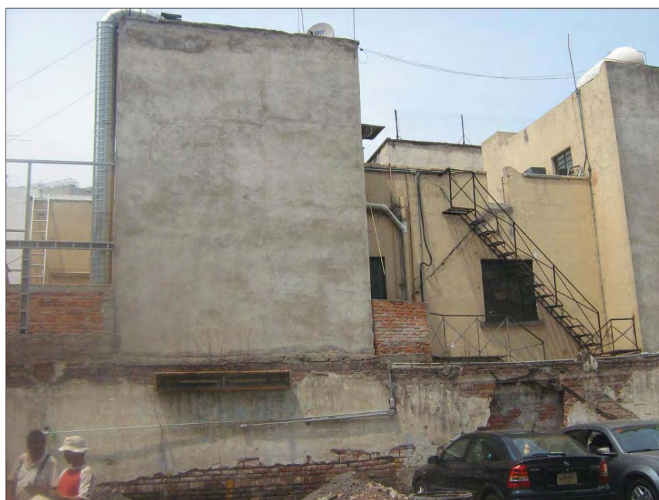
Otra vista del edificio de tres niveles colindante hacia el poniente
