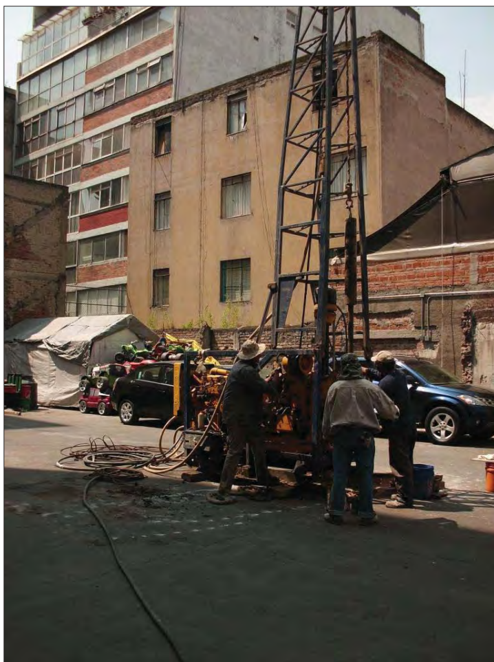
Vista de los edificios de cuatro y siete niveles colindantes hacia el poniente
