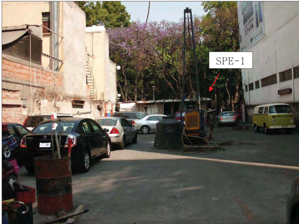
Vista del predio hacia el norte
