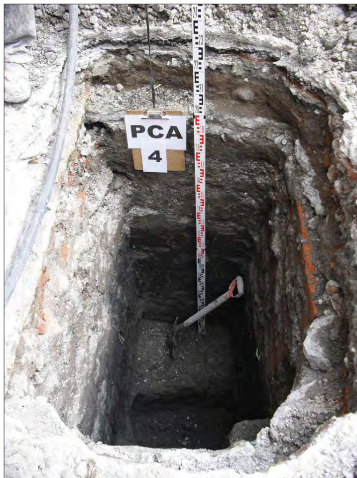
Pozo a cielo abierto PCA-4. Cara sur
