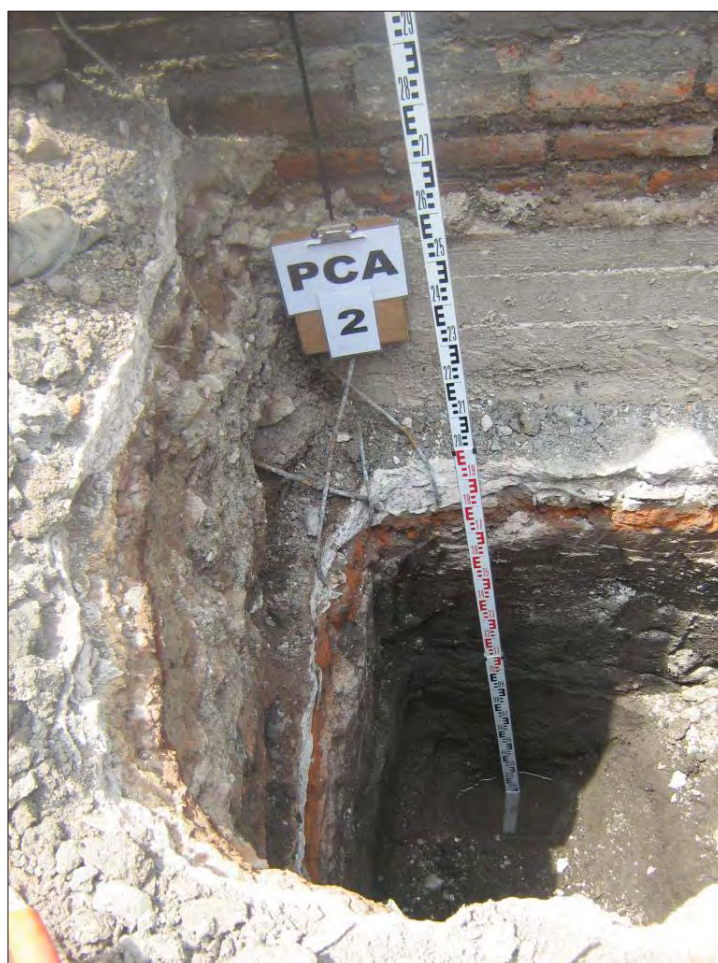
Pozo a cielo abierto PCA-2. Cara poniente
