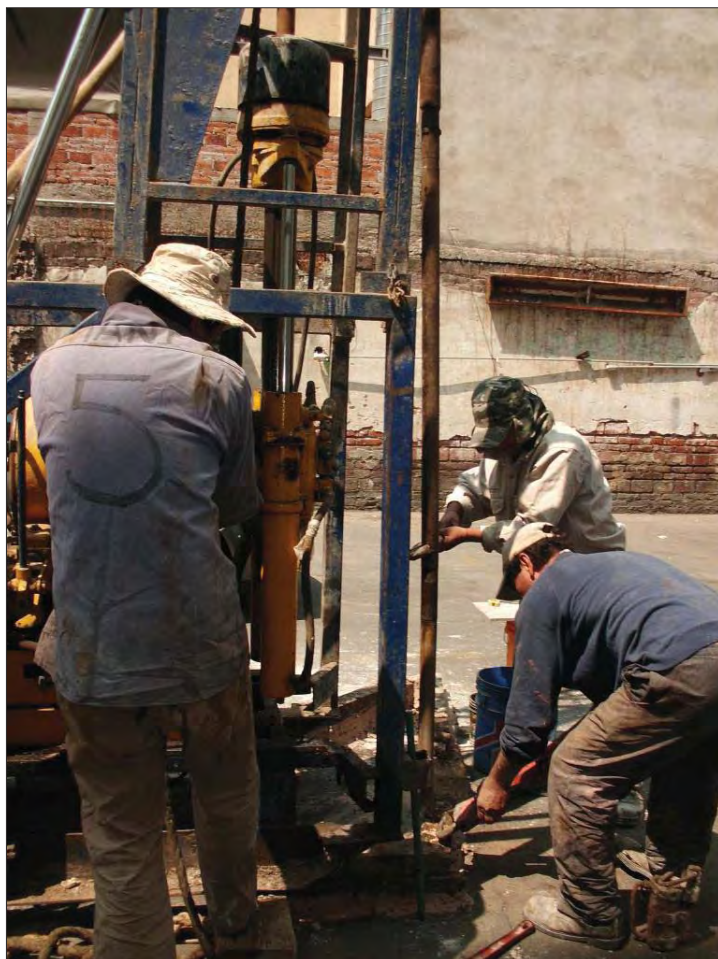
Ejecución del sondeo de penetración estándar SPE-1
