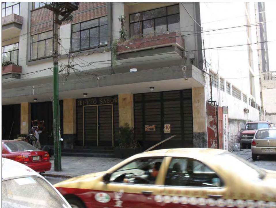
Vista del edificio de siete niveles colindante hacia el oriente
