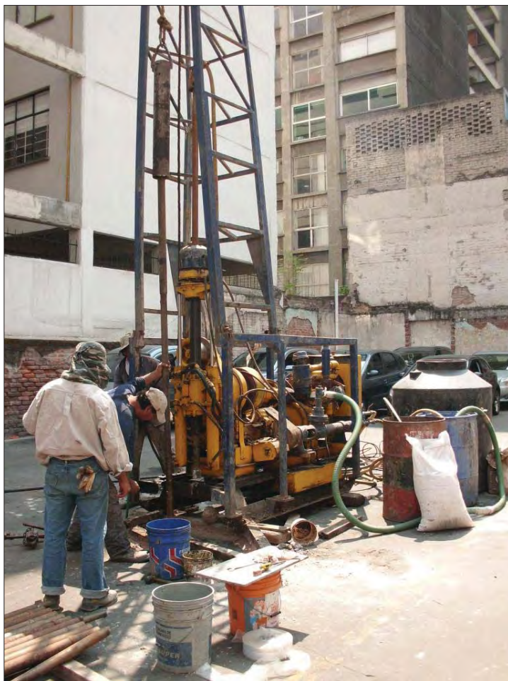
Otra vista de la ejecución del sondeo de penetración estándar SPE-1
