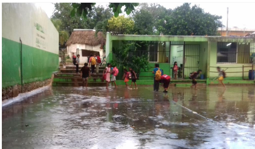
Imagen 41. Edificio escolar (fotografía del autor).
