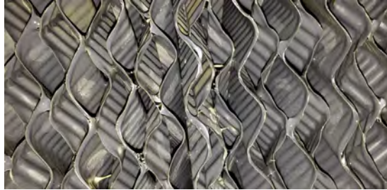
Figura 5.3: Corrugado interno de la torre de enfriamiento Delta T
