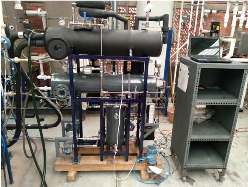
Figura 3.12: Sistema ensamblado de refrigeración por absorción
