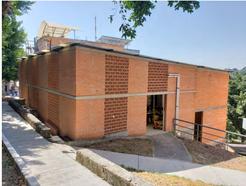
Figura 3.1: Laboratorio de Refrigeración y Bombas de Calor, IER-UNAM
