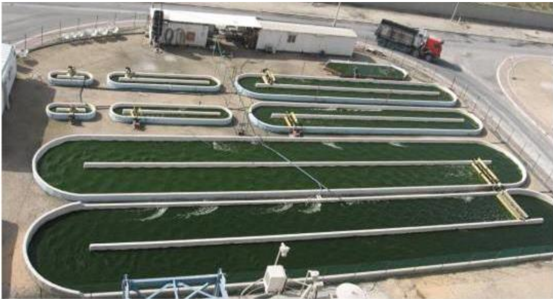
Figura 7: Fotografía de un conjunto de reactores de alta tasa para la producción de microalgas de la Universidad estatal de Colorado, EUA (Marchese y Bradley, 2011)
