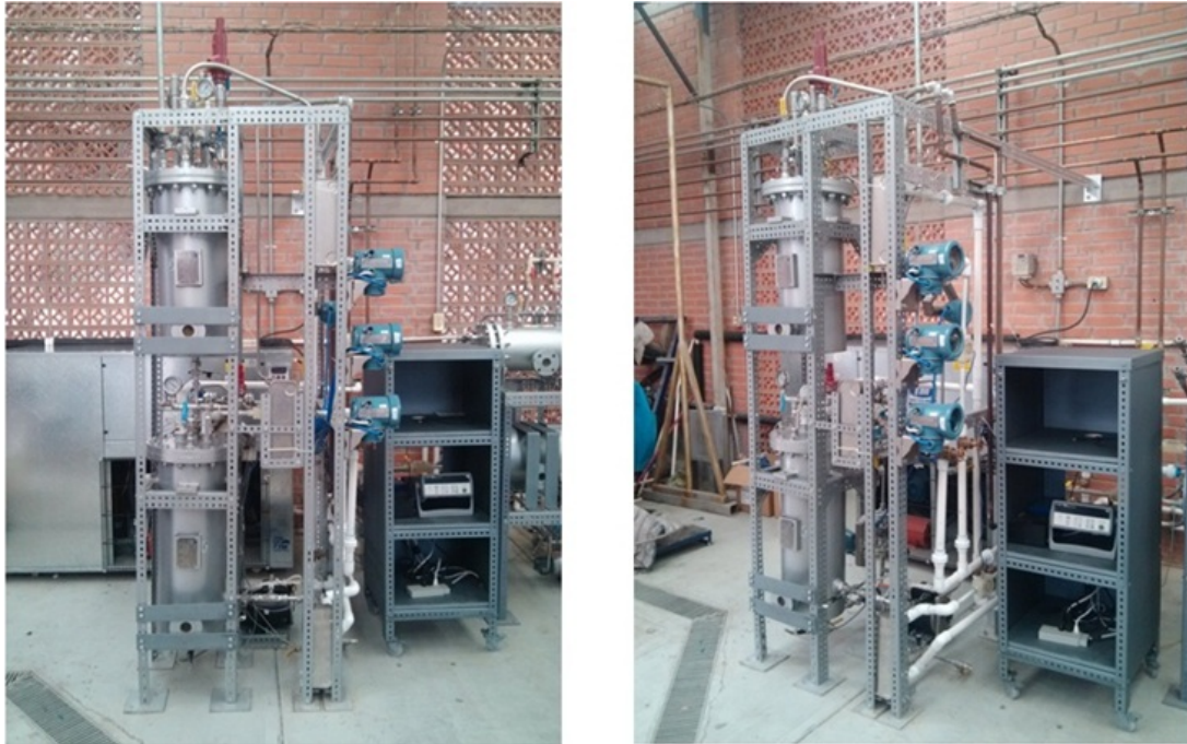
Figura 3.9. Fotografía del sistema de refrigeración.
