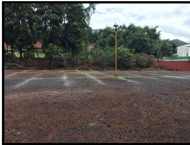
Imagen 3.17. Interior de estacionamiento 5.
