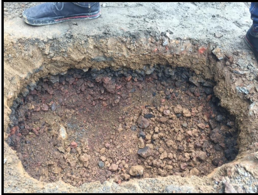
Imagen 3.30. Pozo a cielo abierto en estacionamiento oriente.
