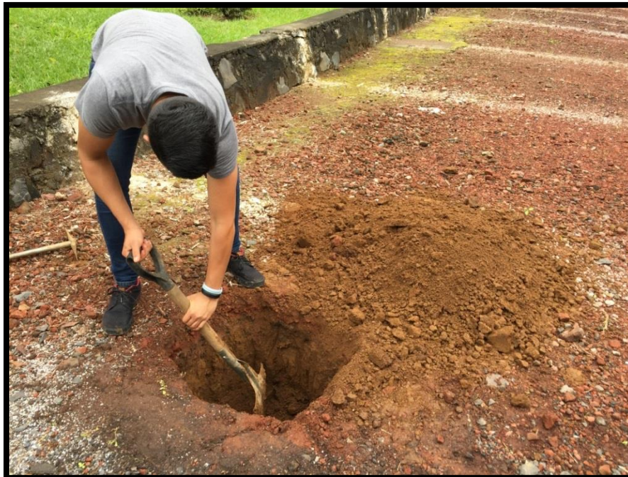
Imagen 3.12. Elaboración de pozo a cielo abierto en estacionamiento 4.
