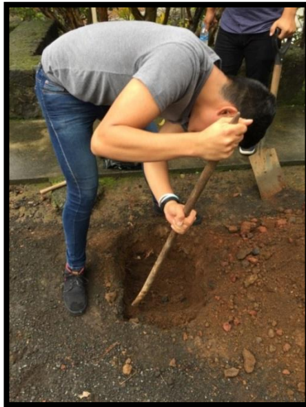
Imagen 3.22. Elaboración de pozo a cielo abierto en estacionamiento 5.
