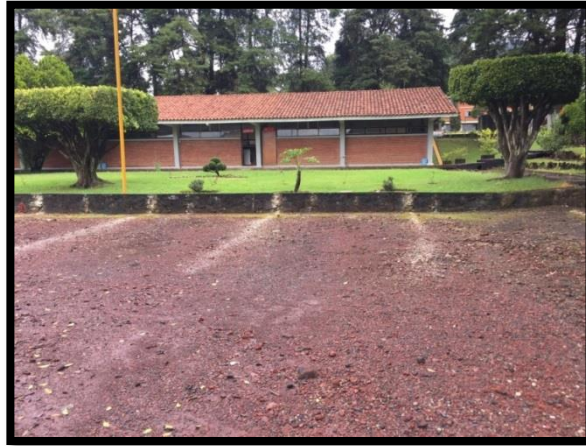
Imagen 3.7. Interior de estacionamiento 4.
