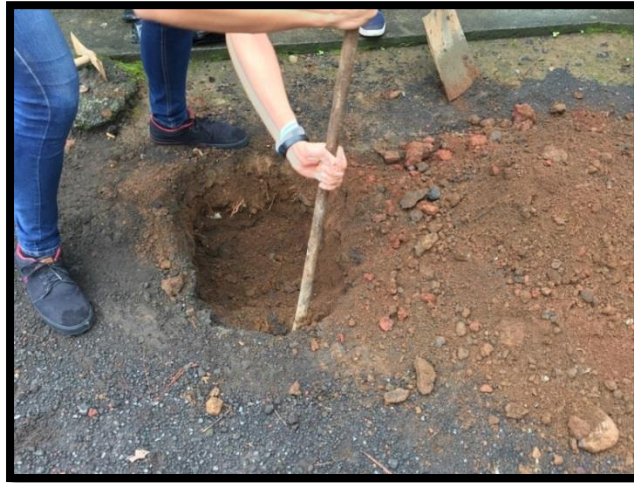
Imagen 3.21. Elaboración de pozo a cielo abierto en estacionamiento 5.
