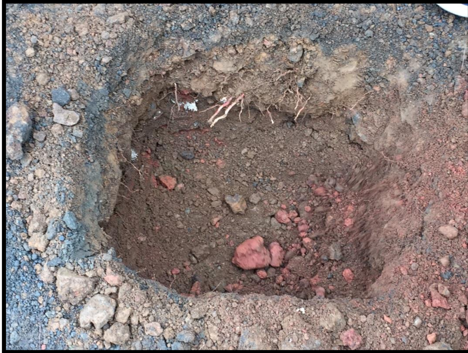
Imagen 3.23. Pozo a cielo abierto en estacionamiento 5.
