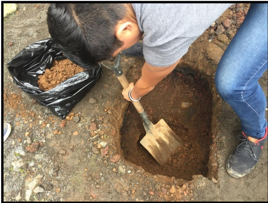
Imagen 3.31. Recolección de material en pozo a cielo abierto en estacionamiento oriente.
