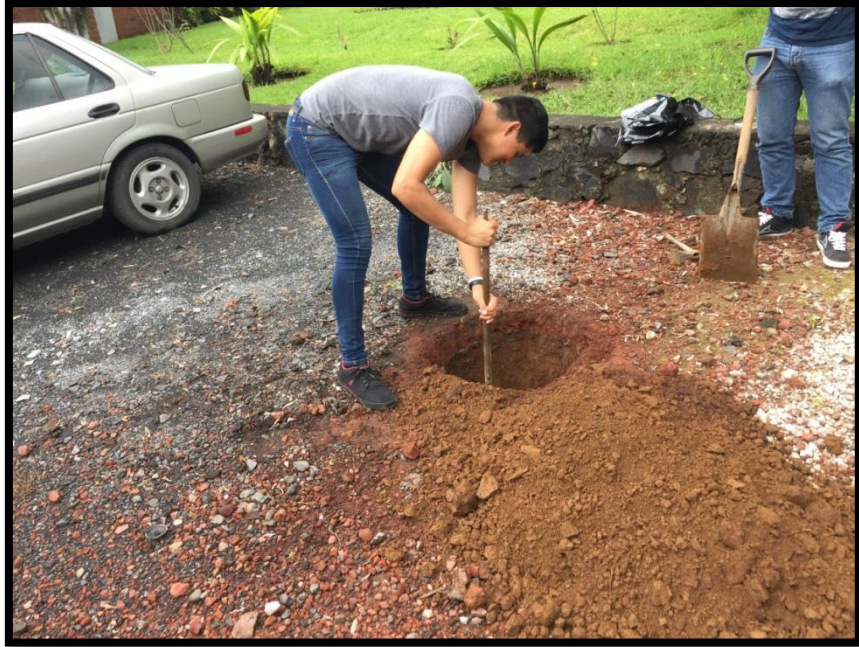
Imagen 3.15. Elaboración de pozo a cielo abierto en estacionamiento 4.
