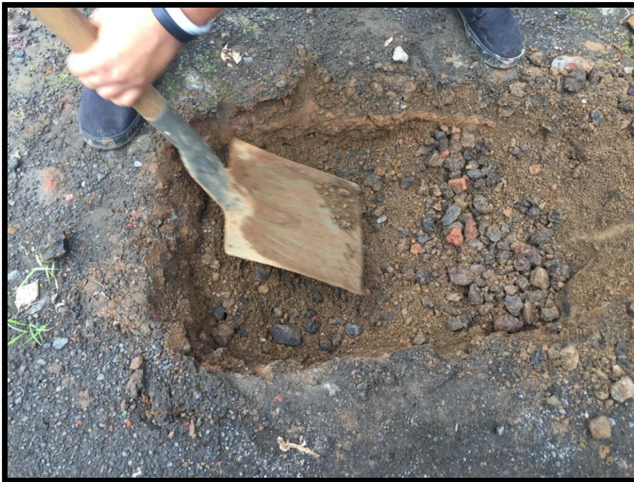
Imagen 3.29. Elaboración de pozo a cielo abierto en estacionamiento oriente.
