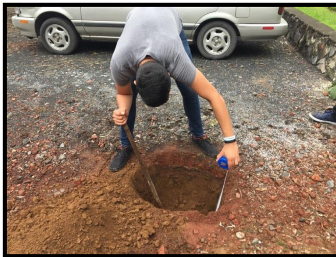
Imagen 3.14. Elaboración de pozo a cielo abierto en estacionamiento 4.
