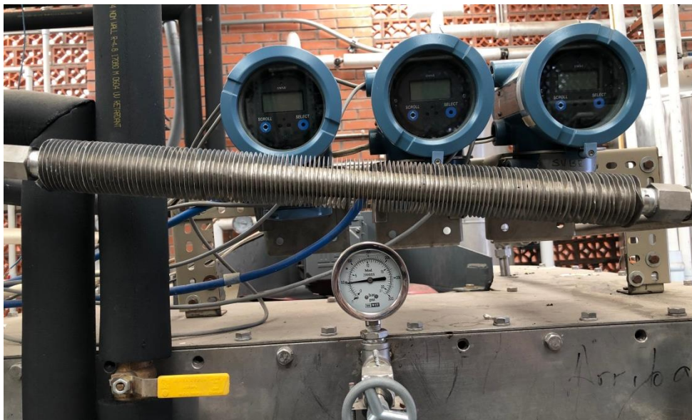
Figura 3.5. Rectificador instalado con la inclinación de 30^\circ .
