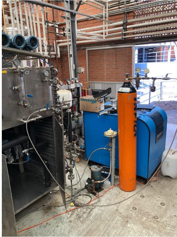
Figura 3.28. Inyección de nitrógeno al sistema por el generador.
