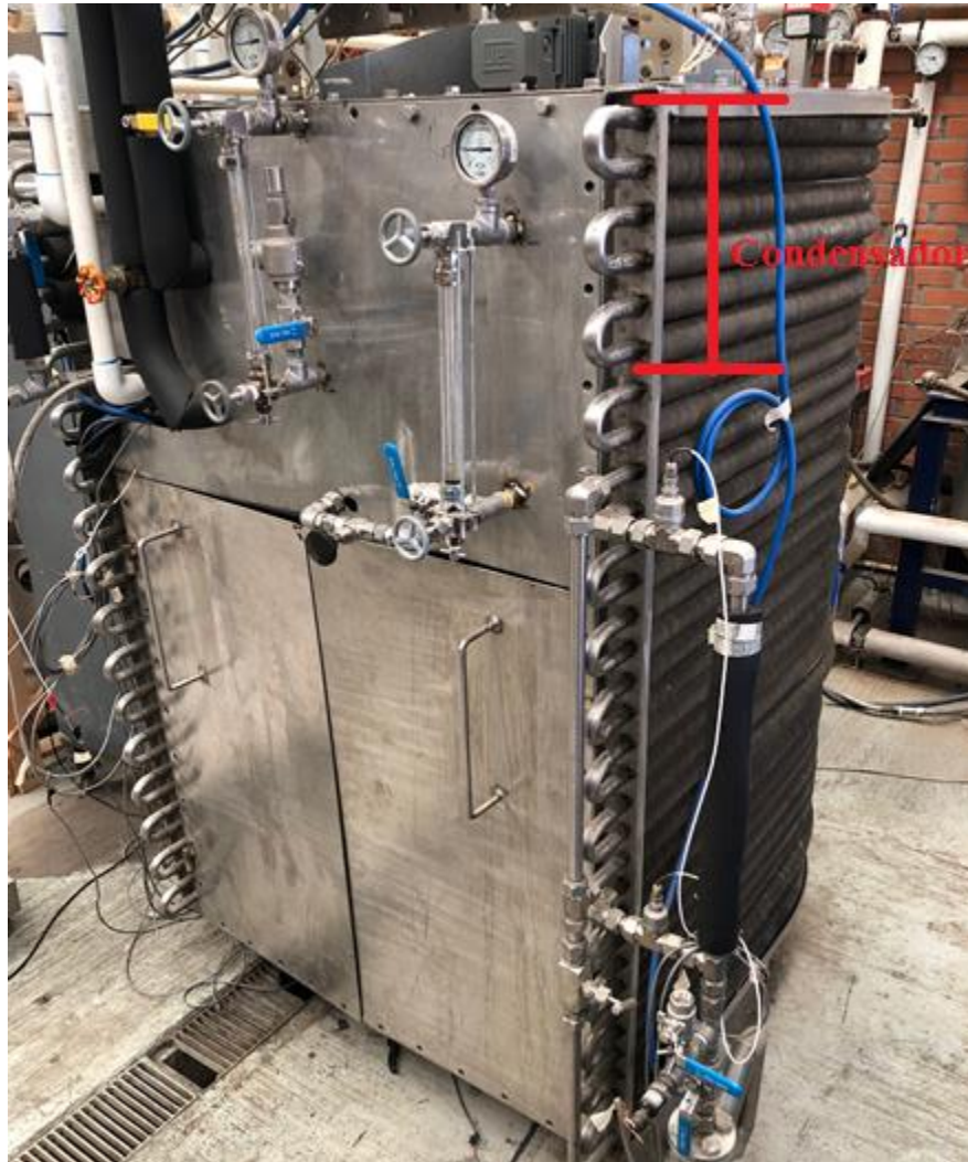
Figura 3.6. Condensador de tubos aletados.
