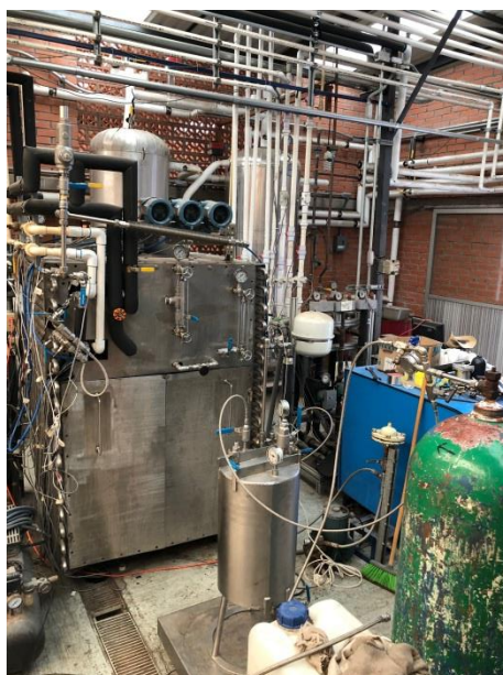
Figura 3.32. Presurización de la boya con vapor de amoníaco.
