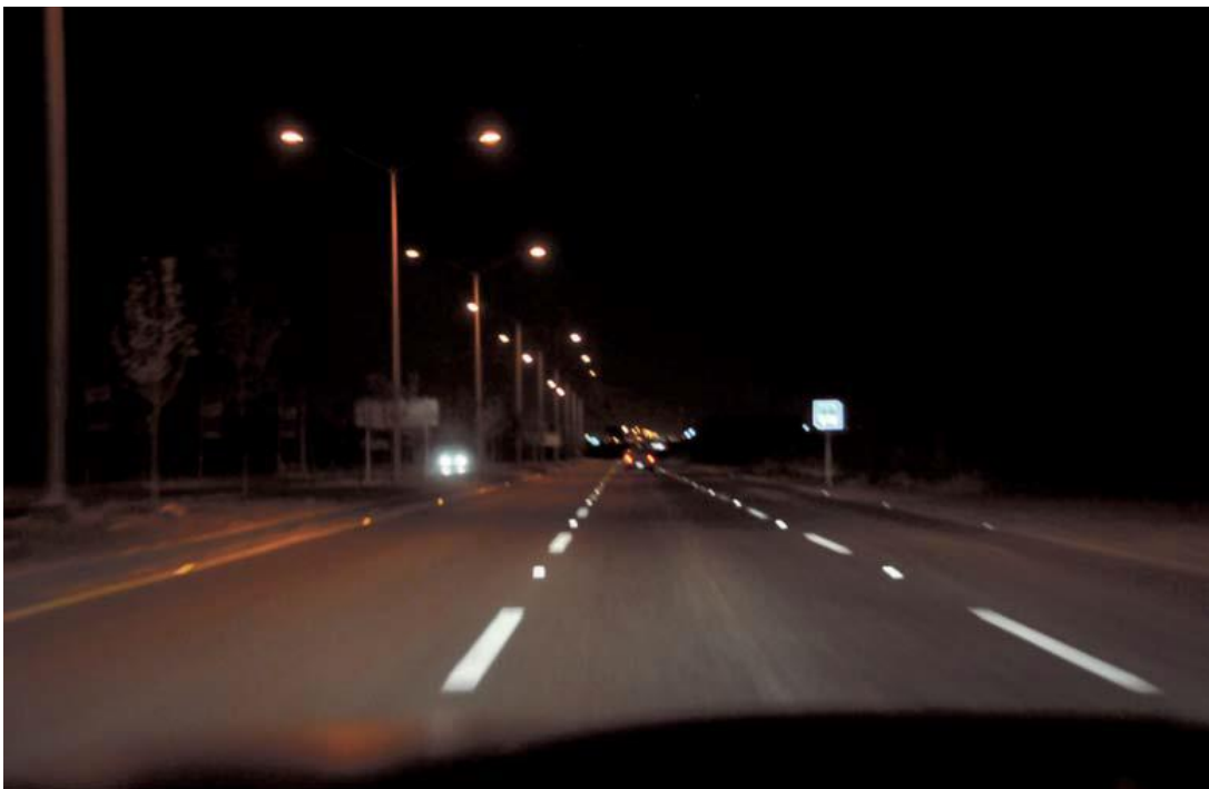
Figura 2.6 Boulevard iluminado con luminarias cut-off (Fuente Manual de iluminación vial SCyT).
