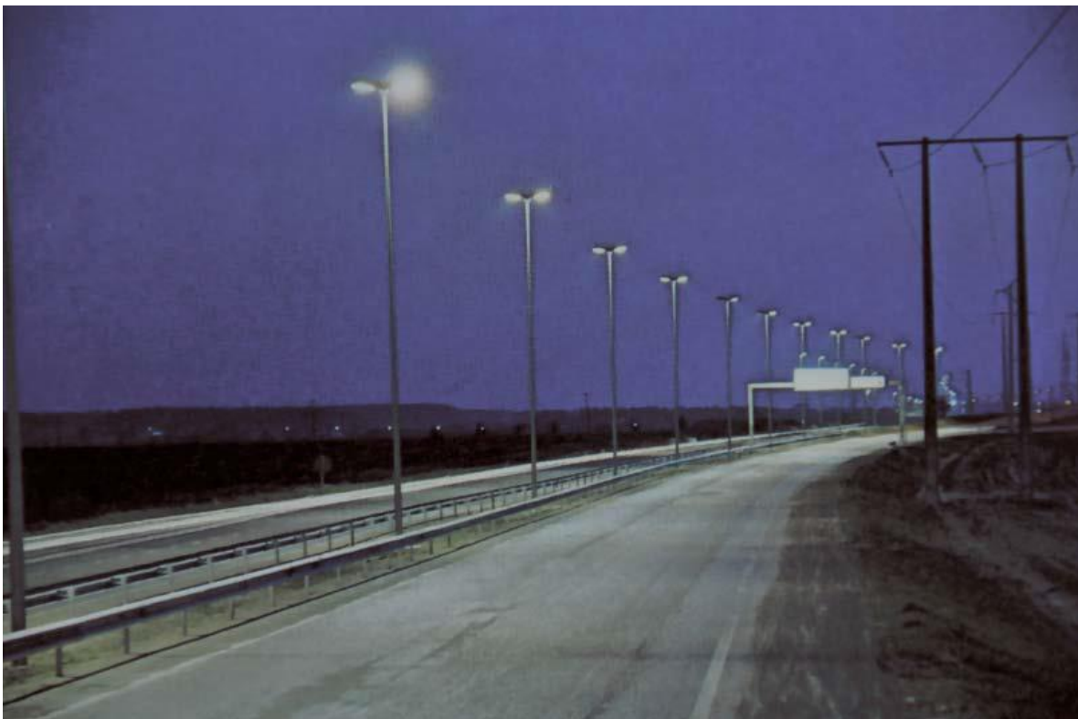
Figura 2.1 alumbrado vial (Fuente Manual de iluminación vial SCyT).
