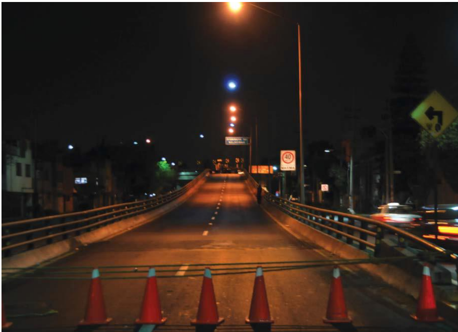
Figura 2.14 Avenida con lámparas de vapor de sodio alta presión y lámparas con aditivos metálicos (Fuente Manual de iluminación vial SCyT).
