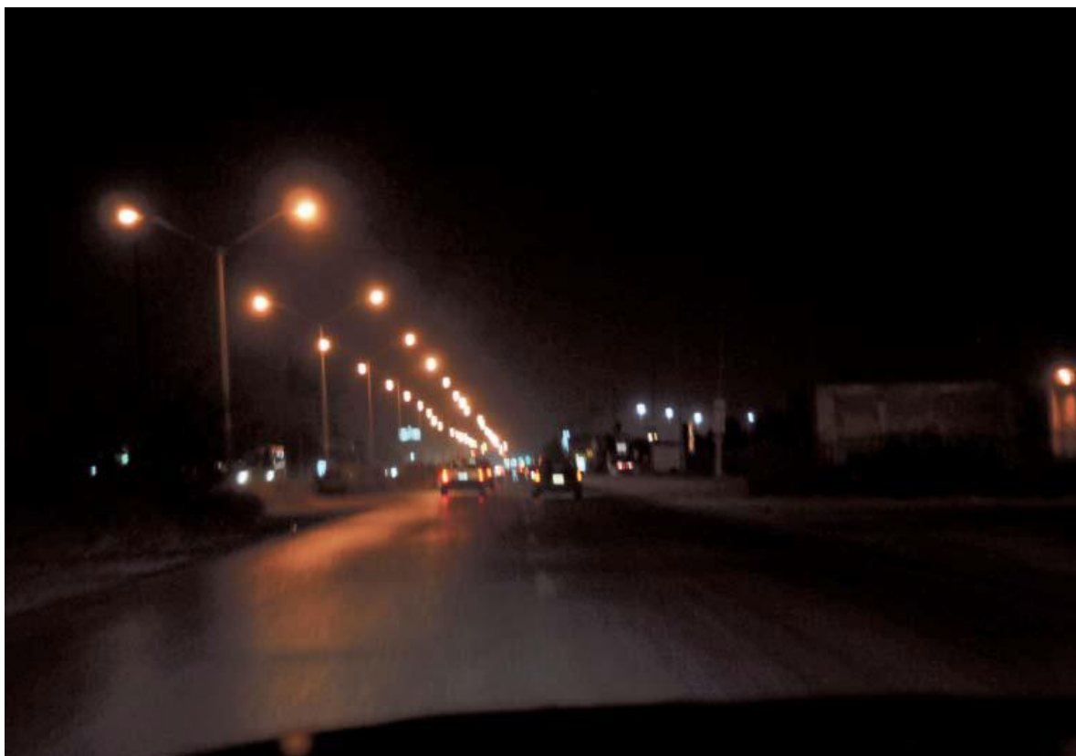
Figura 2.8 Boulevard iluminado con luminarias OV non cut-off (Fuente Manual de iluminación vial SCyT).
