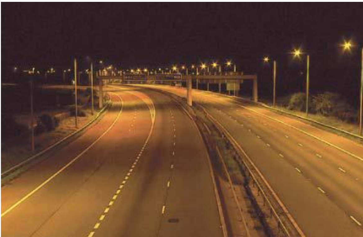
Figura 2.19 Carretera iluminada (Fuente Manual de iluminación vial SCyT).
