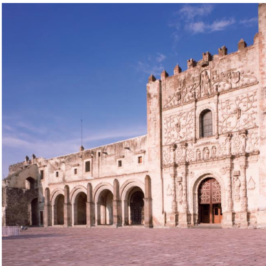
Figura 75. Fachada de convento de Yuririapúndaro. En A. González L. (2008, p. 4).
