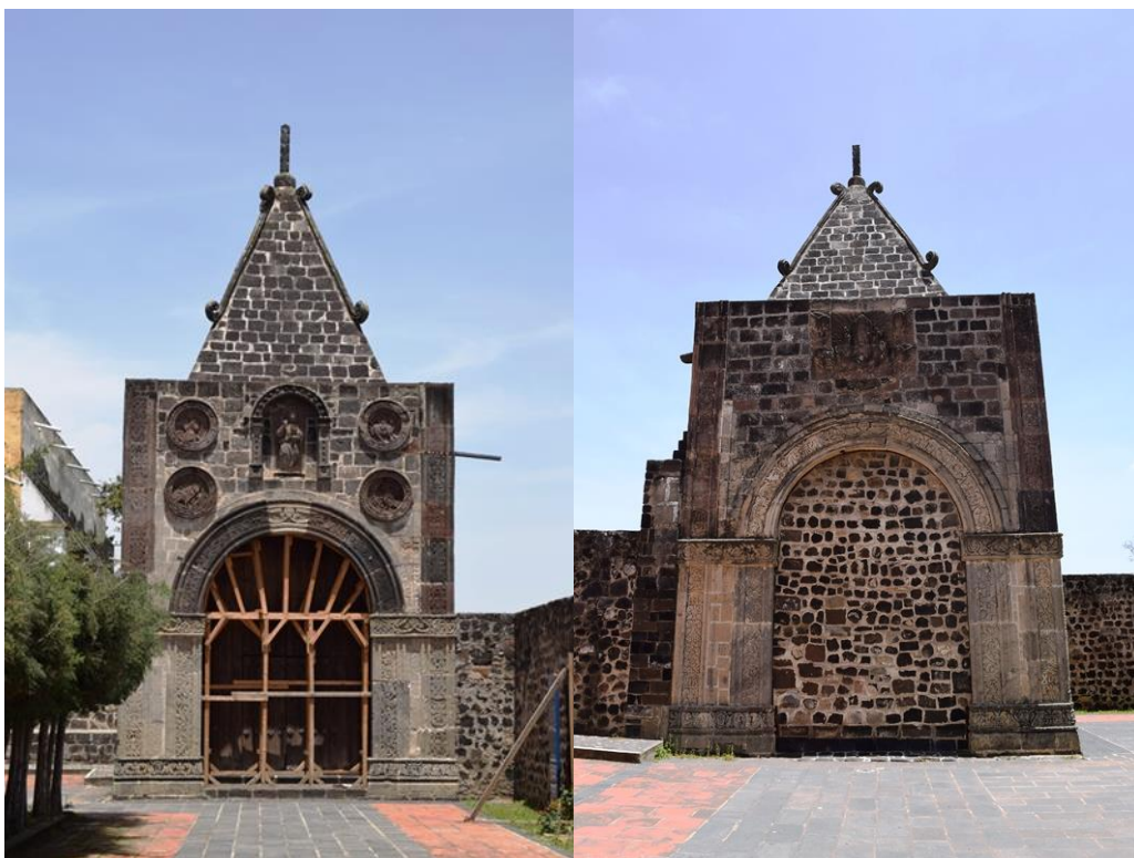
Figuras 160 y 161 Paramentos poniente y norte de la capilla posa del convento de Calpan dedicada a San Juan Evangelista. Fotos de David Ramos.
