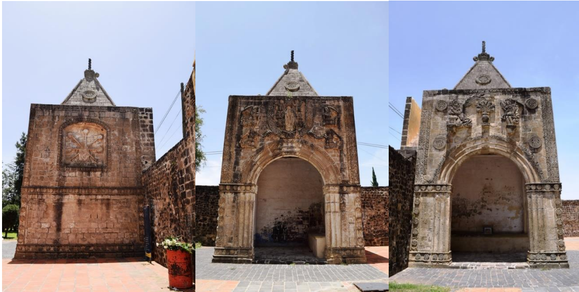
Figuras 152, 153 y 154. Paramentos oriente, sur y poniente de la capilla posa del convento de Calpan dedicada a la Asunción de la Virgen María. Fotos de David Ramos.
