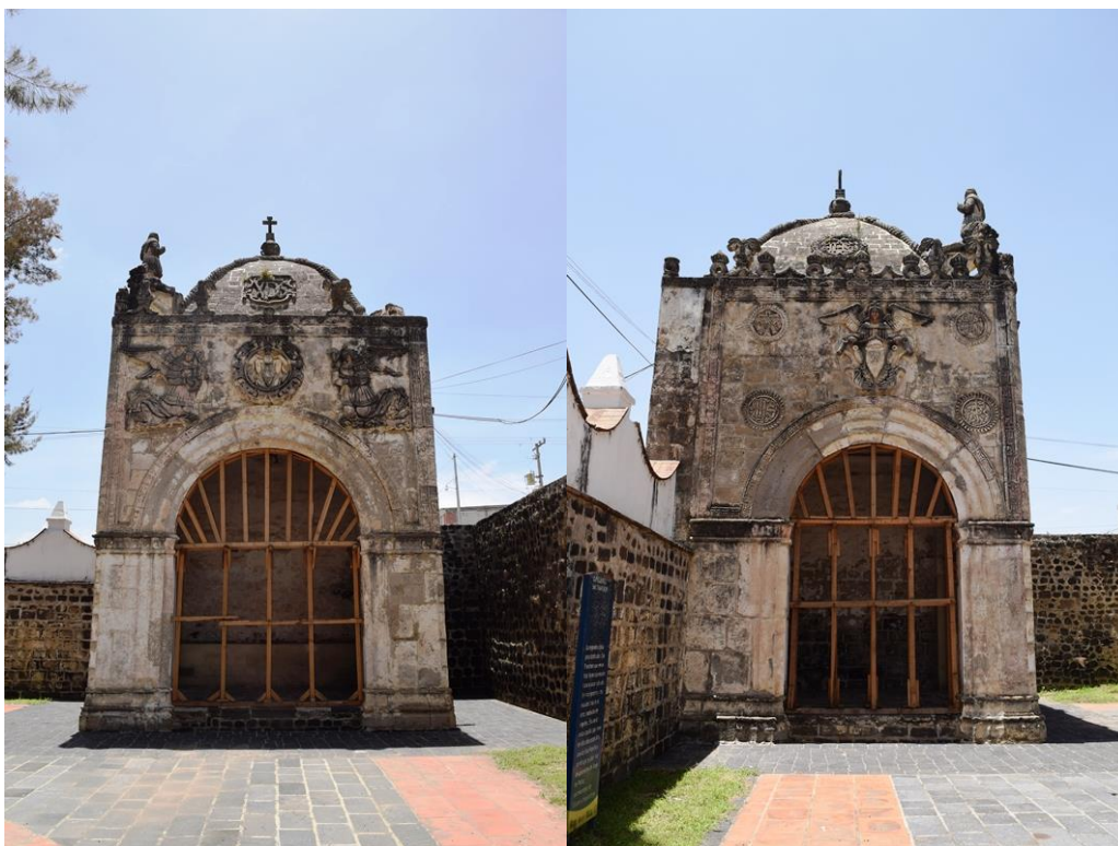
Figuras 155 y 156. Paramentos oriente y sur de la capilla posa del convento de Calpan dedicada a San Francisco de Asís. Fotos de David Ramos.
