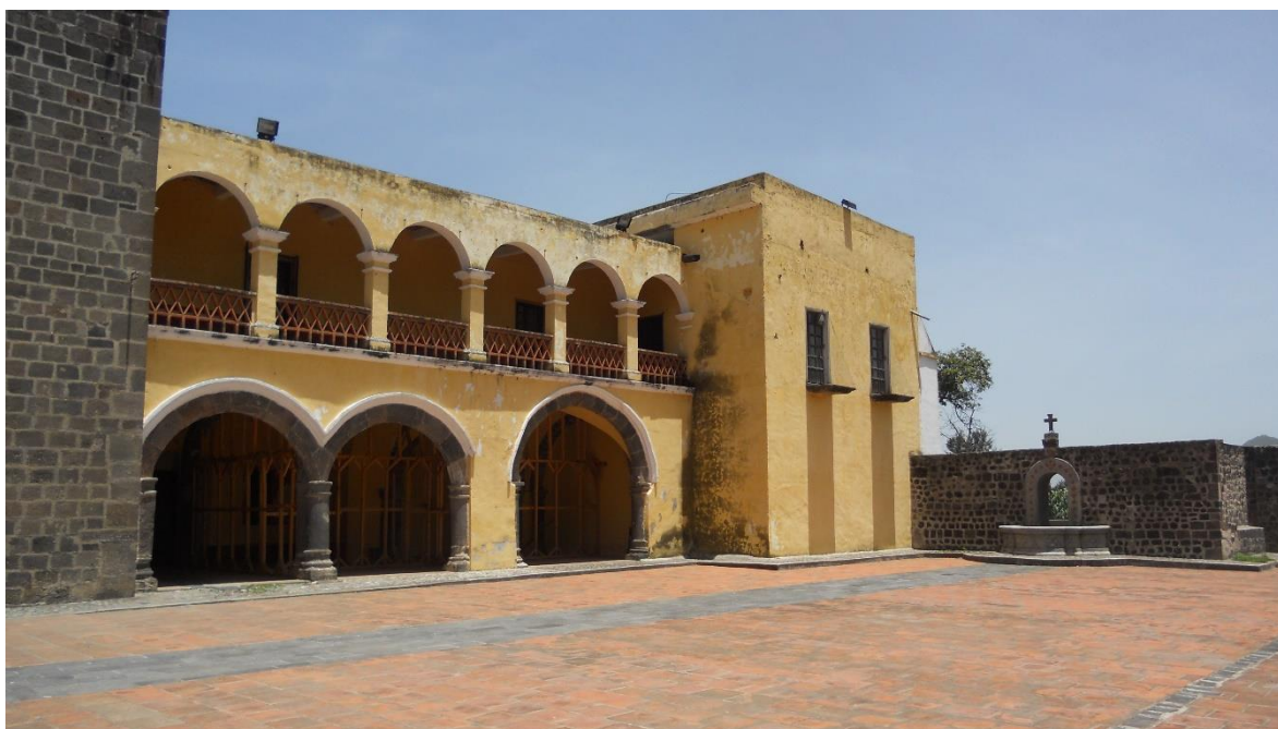
Figura 143. Portería, capilla abierta y galería-mirador del convento de Calpan. Foto del autor.
