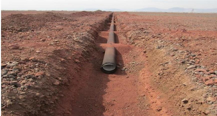
Figura 2.13 Drenaje horizontal de agua de precarga hacia los drenes THPD
