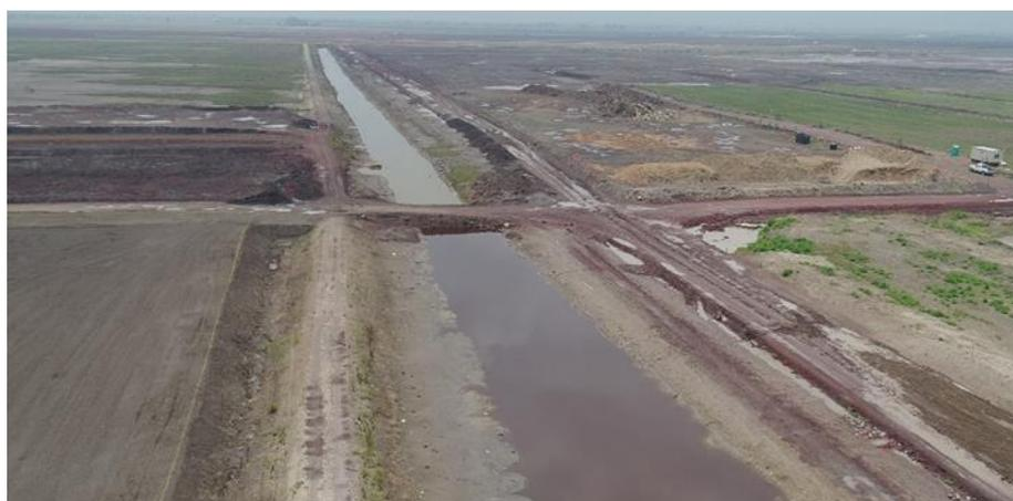
Figura 4.3 Obstrucción en el Dren secundario Canal 4 que conecta al DPTM-3 con el DPTM-2.
