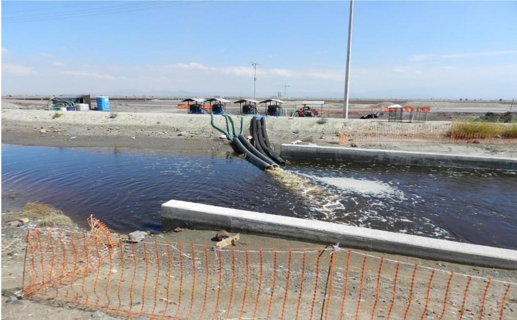
Figura 2.9 Descarga de agua de precarga, hacia un dren DPTM principal.
