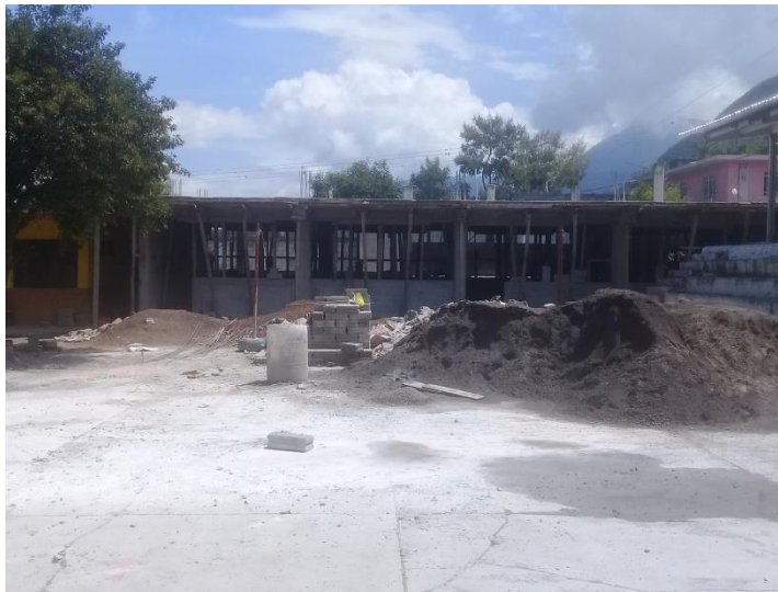
Salones en construcción
