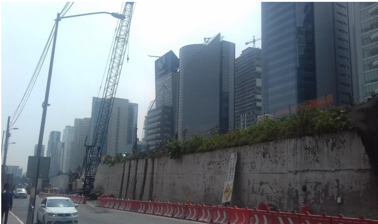
Figura 60: Obras del Tren México- Toluca a la altura del Centro Comercial Santa Fe [Foto] elaboración propia
