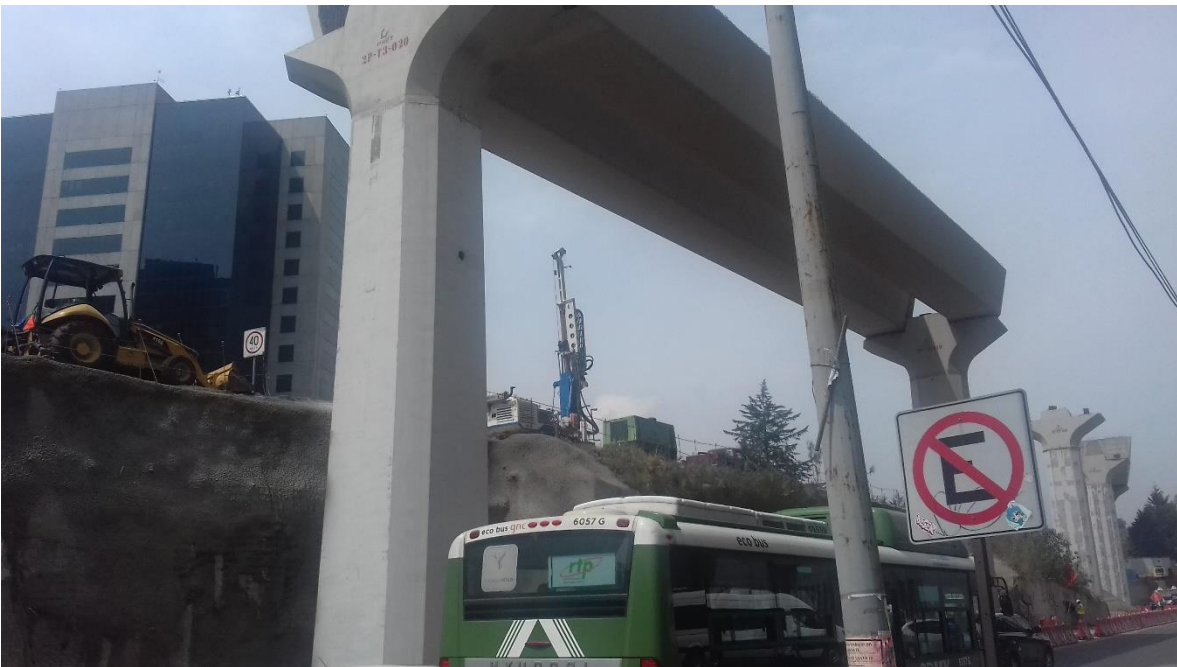
Figura 61: Ballena del Tren México Toluca, Santa Fe [Foto] elaboración propia
