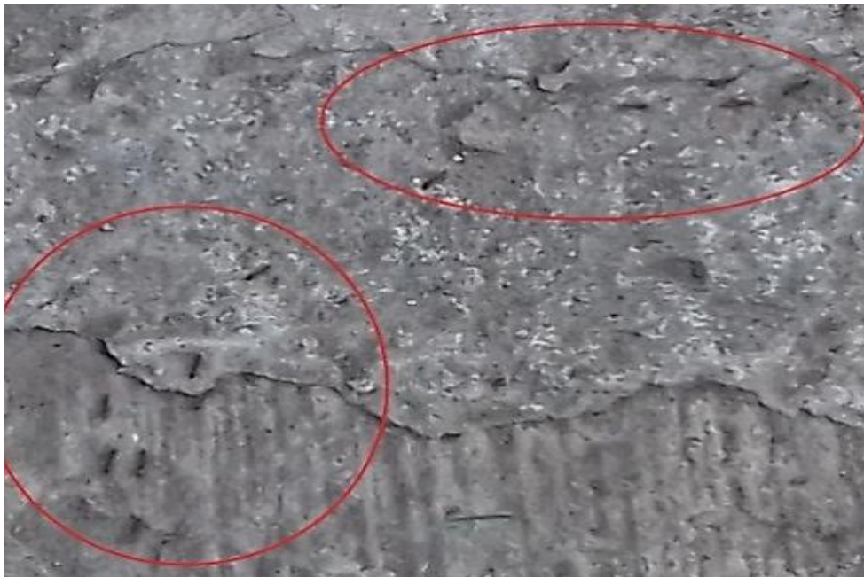
Figura 21. Plaga de hormigas en el estacionamiento.
