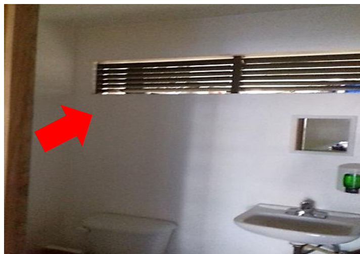
Figura 14. Ventilación del sanitario.
