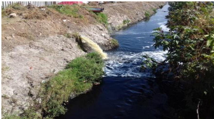
Figura 2. Entorno de las instalaciones.
