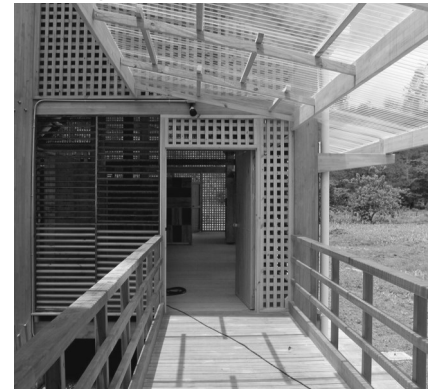
Imagen 4.17 Vista del pasillo
