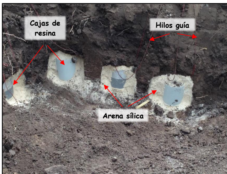
Figura 6.8. Instalación de las cajas de resina dentro del perfil de suelo
