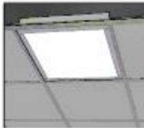
Lucernario para empotrar de 24w, modelo 187, marca PTILIGHTING con fuente de luz tipo fluorescente led lineal T-5 de 24w.
