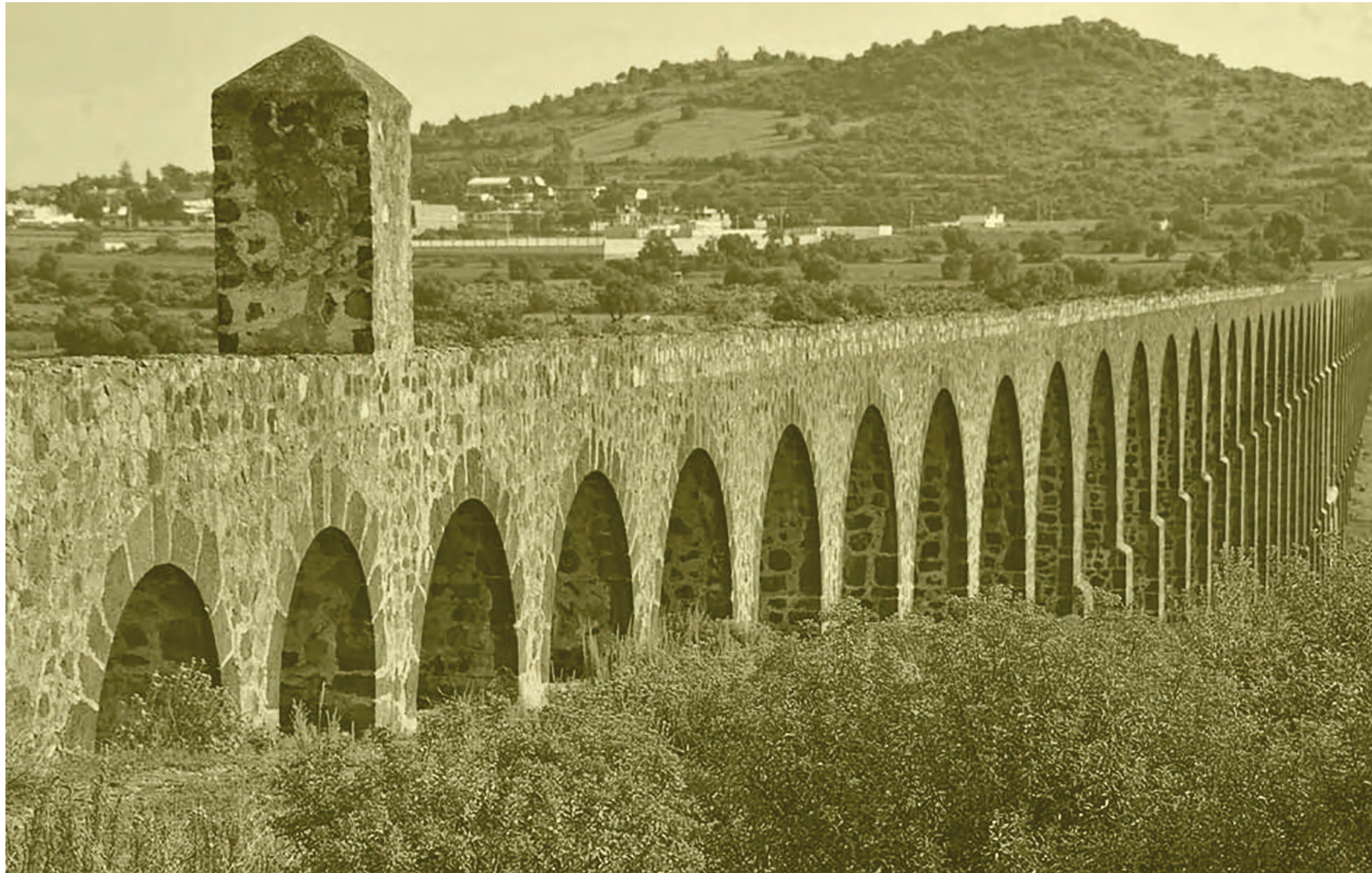
Imagen 05 Acueducto del Padre Tembleque
