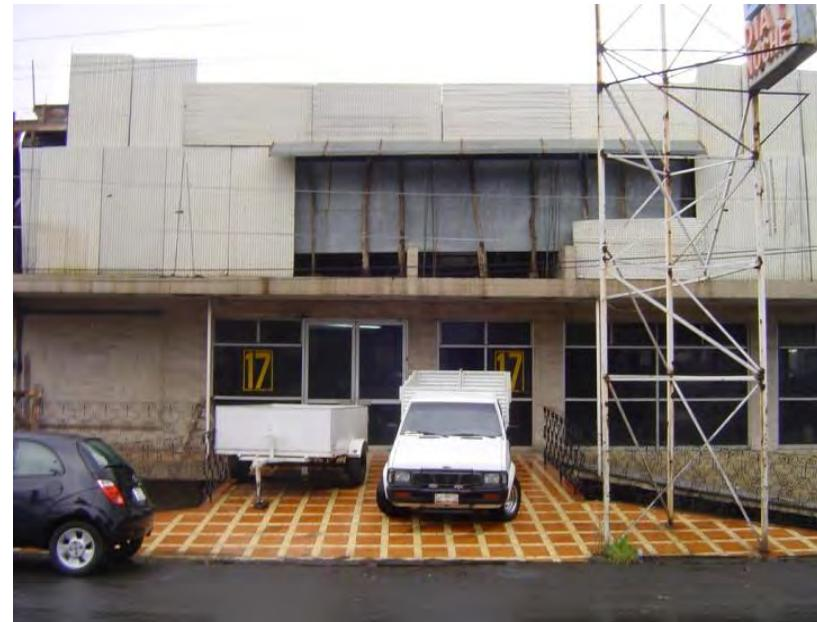
El derribo de los tabiques y falsos techos deja la estructura original a la vista, con paredes de ladrillos, vigas y pilares de hierro. La estructura se respetó solo se realizaron algunos cambios y se adosó un nuevo volumen construido con materiales prefabricados, que jerarquiza el acceso principal.
