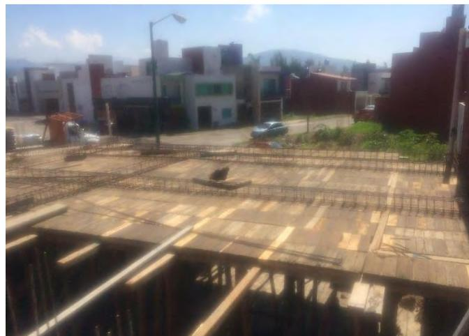
Colocación de cimbra para armado de losa entrepiso
