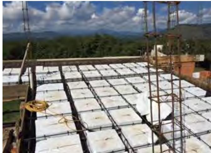
Armado de losa de casetón
