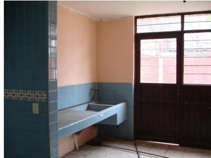
La cocina se sustituyó por completo. El primer paso fue cambiar el drenaje, posteriormente se retiró el azulejo y se abrió un vano donde está ubicada una ventana que da hacia el área de servicio, ya que antes se iluminaba y ventilaba mediante un domo que fue eliminado.
