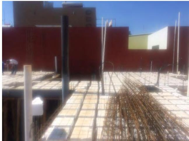
Armado de losa de casetón y columna metálica
