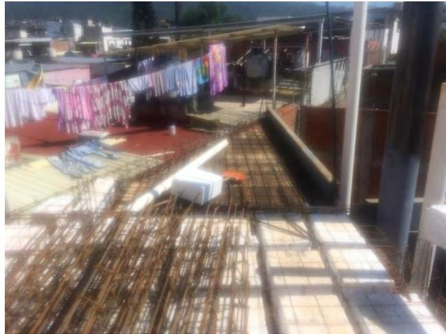
Armado de losa de casetón y losa maciza
