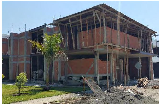
*Obra preparada para colar 2da losa*
