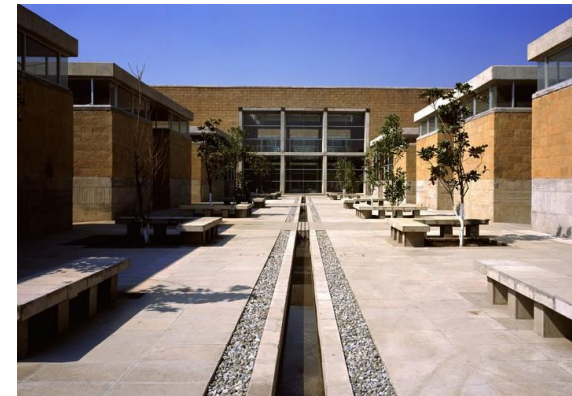
Imagen 9. Corredor interior del proyecto
