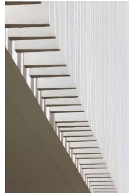
Imagen 11. Detalle de parteluces en fachada
