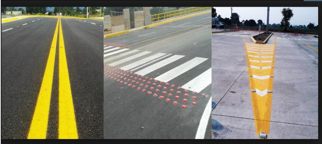
**Imagen 6.9.-** Señalamiento horizontal: señalamiento plasmado en concreto o carpeta asfáltica.
