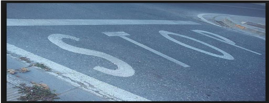
**Imagen 6.10.-** Señalamiento horizontal: señalamiento plasmado en concreto o carpeta asfáltica.
