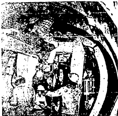
Fig. 98.- Traslado de una sección de cimbra.
