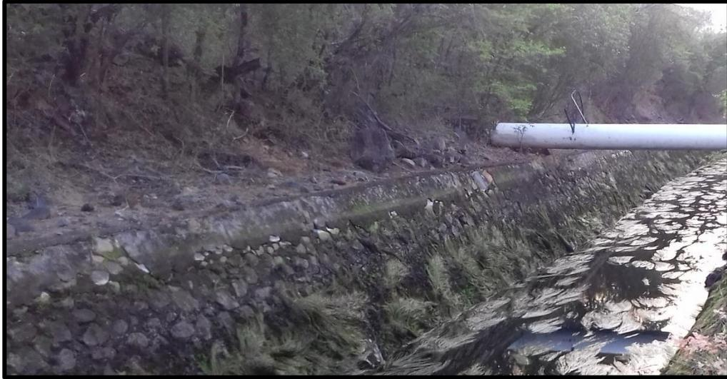
Fotografía 3.3 Socavación de las paredes.
