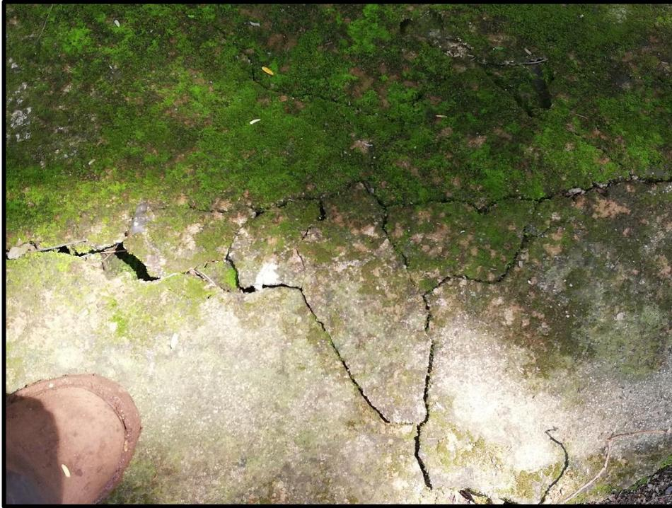
Fotografía 3.5 Agrietamiento del revestimiento.
