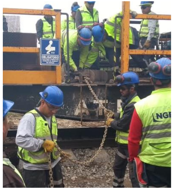
Fig. 43.- Descenso de guía y cadena.
