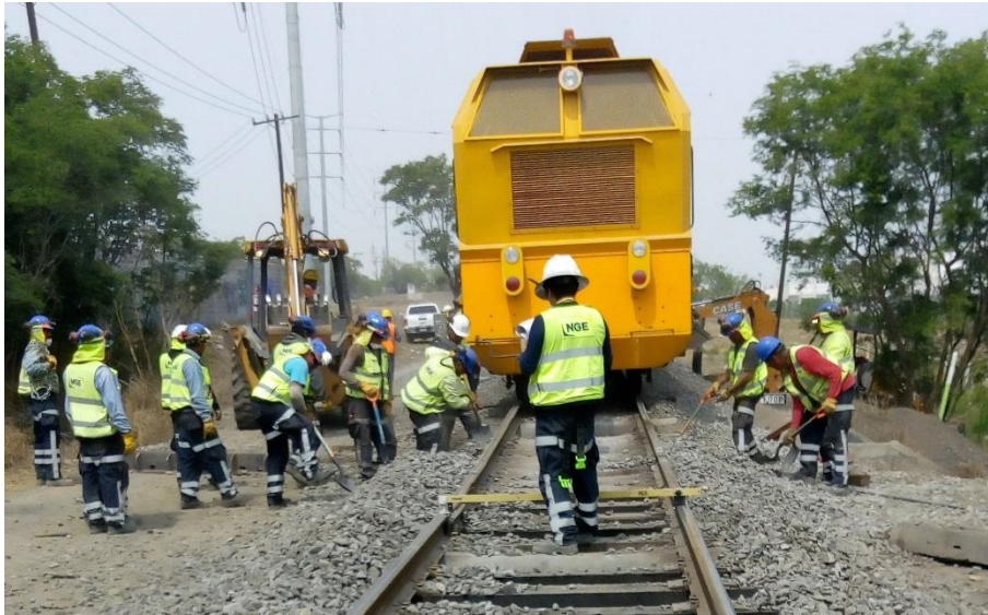
Fig. 48.-rectificación de escantillón de vía.
