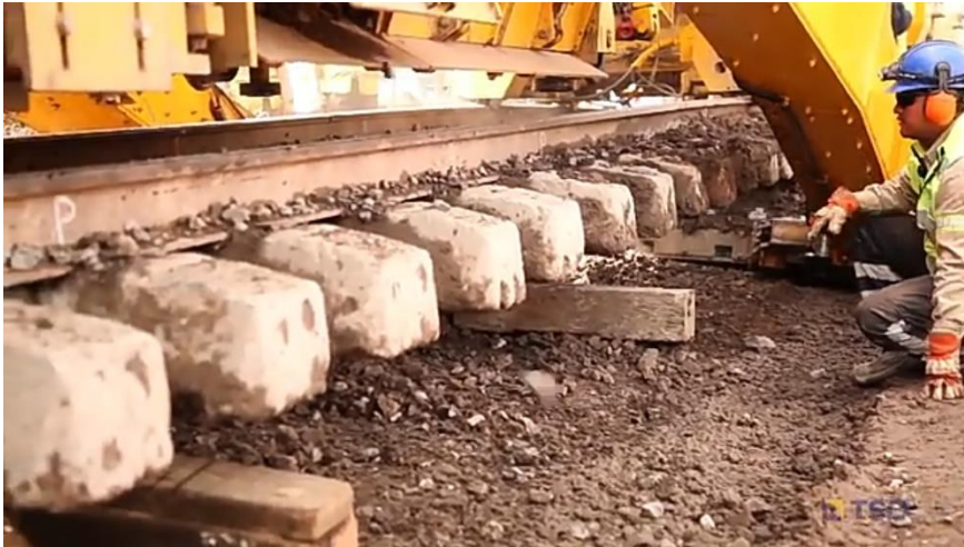
Fig. 42.- Colocación de durmientes de soporte.
