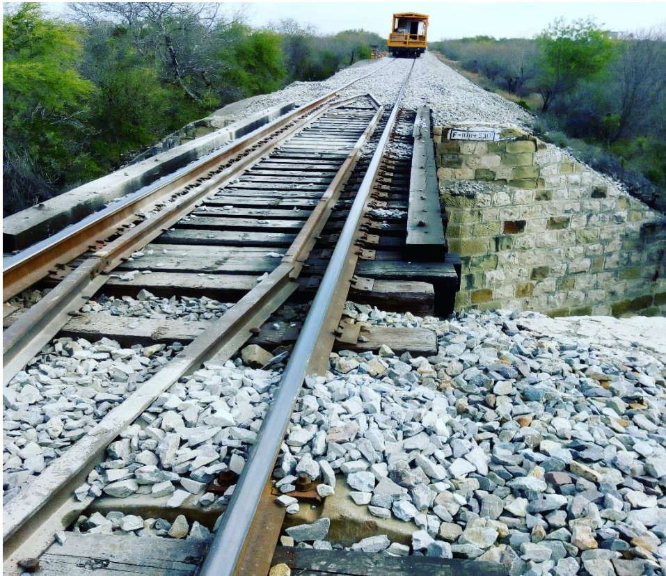
Fig. 154 - Renovación de balasto, Nuevo León México.
