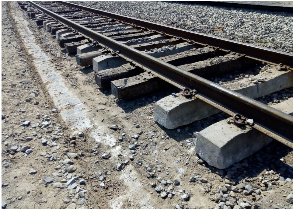
Fig. 22.- Vía sin lecho de balasto.
