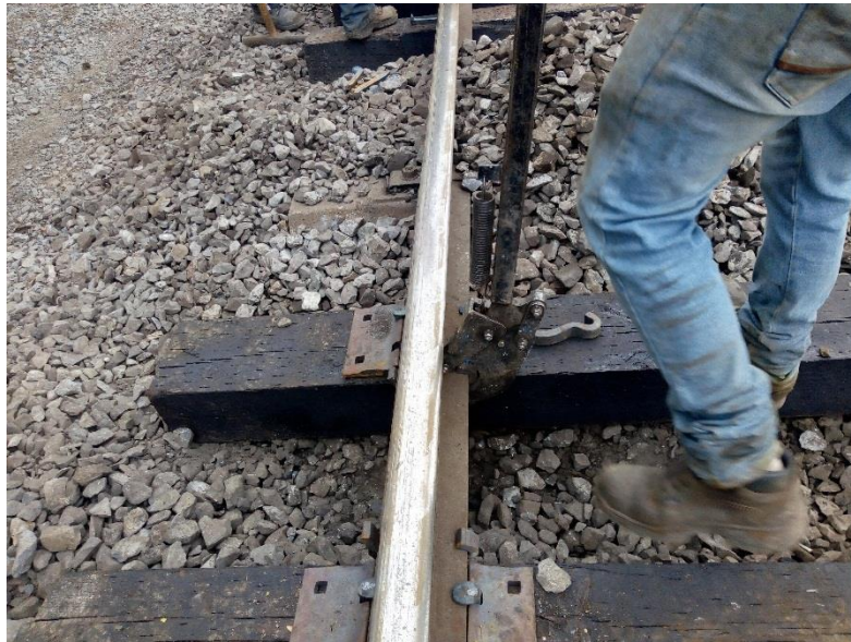
Fig. 39.- Personal de vía colocando fijaciones faltantes.
