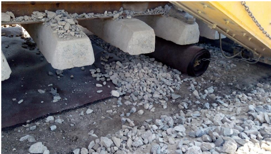
Fig. 46.- Colocación de geotextil.
