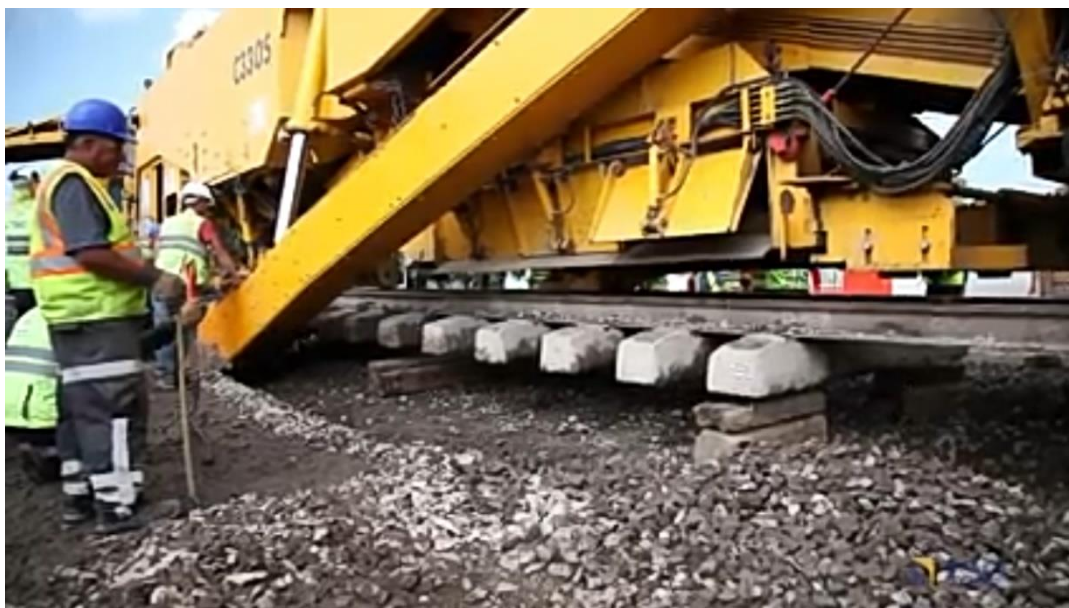
Fig. 41.- Rampa de descenso o entrada de máquina.
