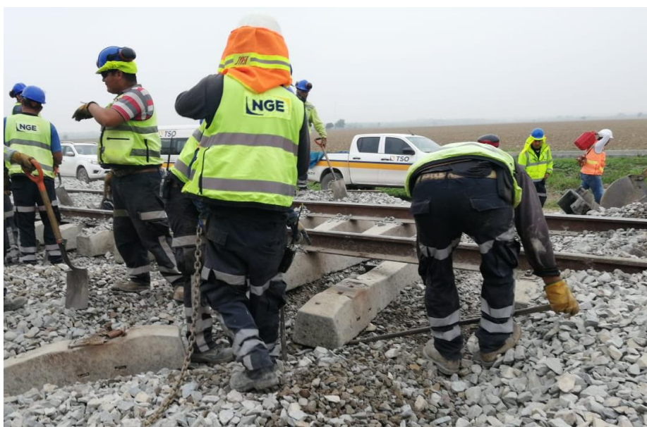
Fig. 40.- Descajonamiento de vía y extracción de durmientes.
