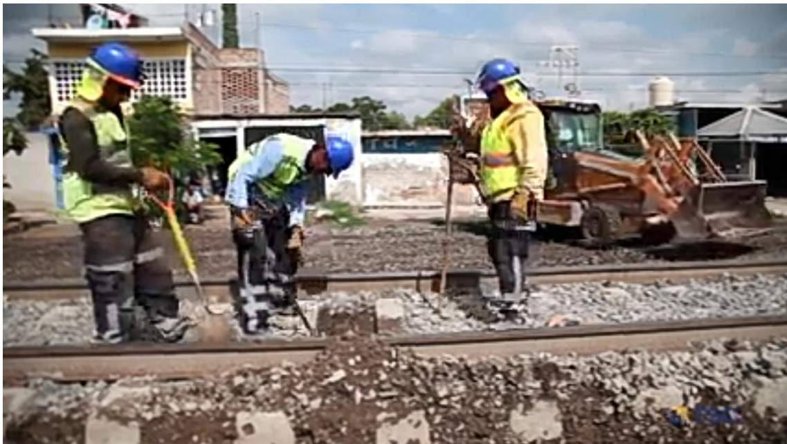
Fig. 47.-Equipo de vías sondeando la vía.
