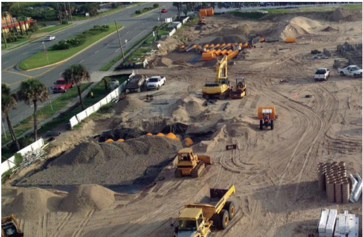
Imagen 17. Fotografía tomada con Dron en una obra de Ingeniería Civil.
