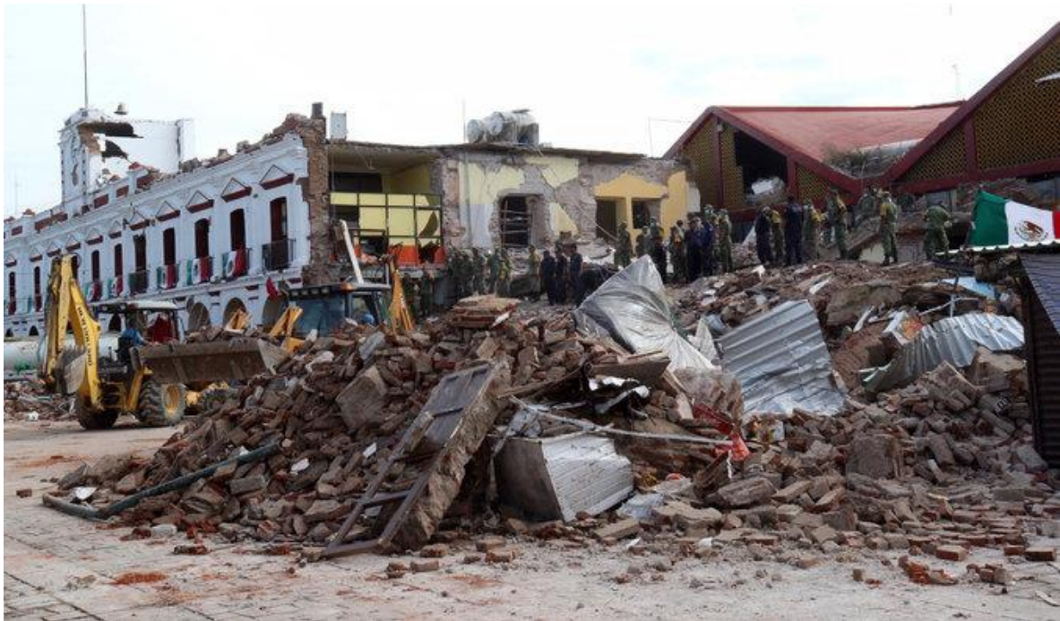
Imagen 34. Daño total en una construcción.
