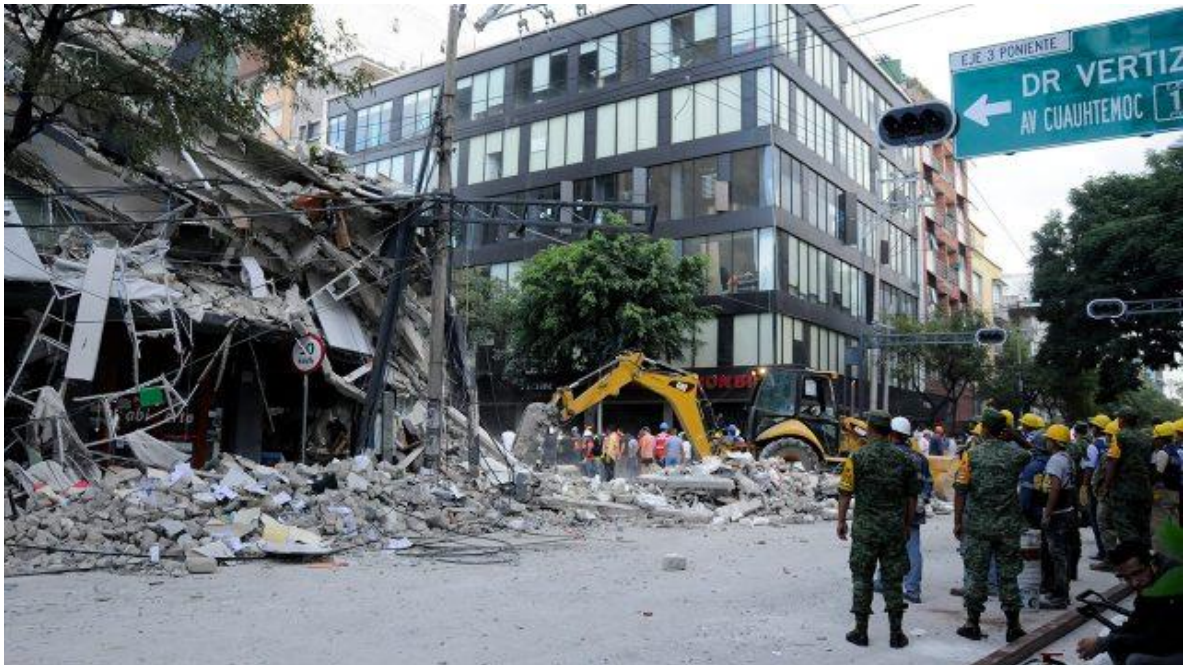
Imagen 35. Daño total de una construcción en la Ciudad de México.
