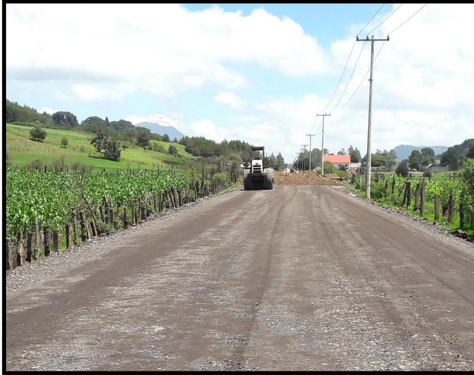
Figura 5.11. Compactado de base hidráulica.
