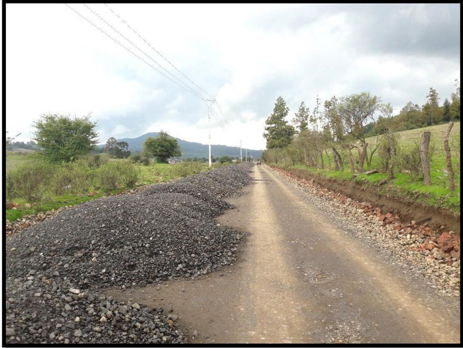
Figura 5.9. Base hidráulica.
