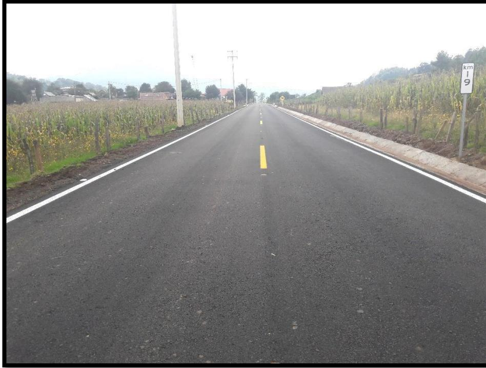
Figura 5.16. Carpeta asfáltica terminada, con señalamiento horizontal y vertical, así como las obras de drenaje ubicadas según el proyecto.
