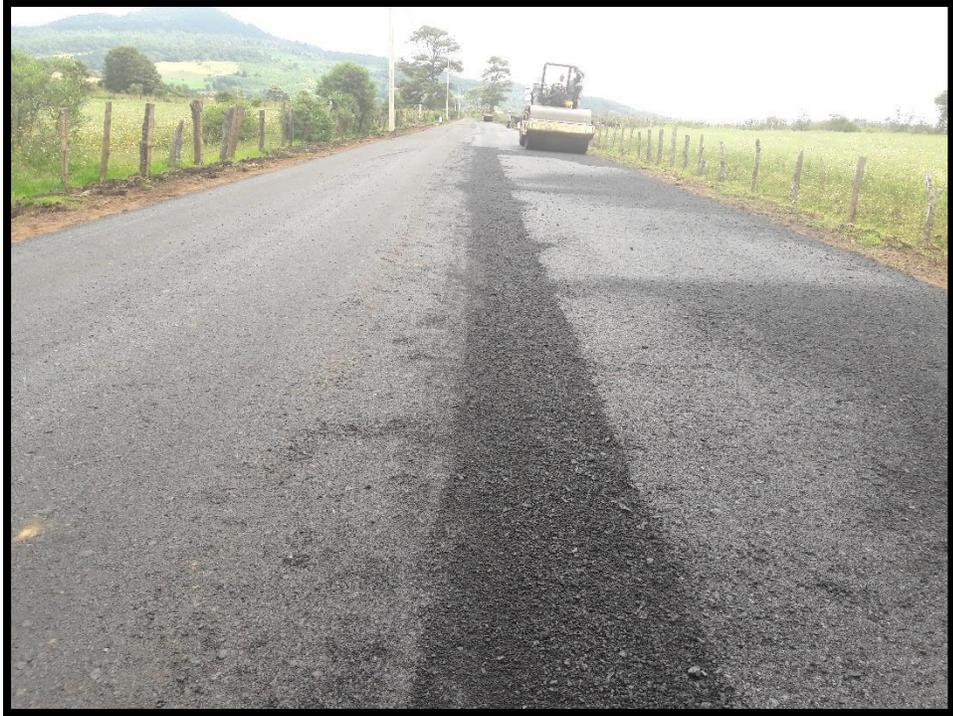
Figura 5.14. Compactado de carpeta asfáltica.
