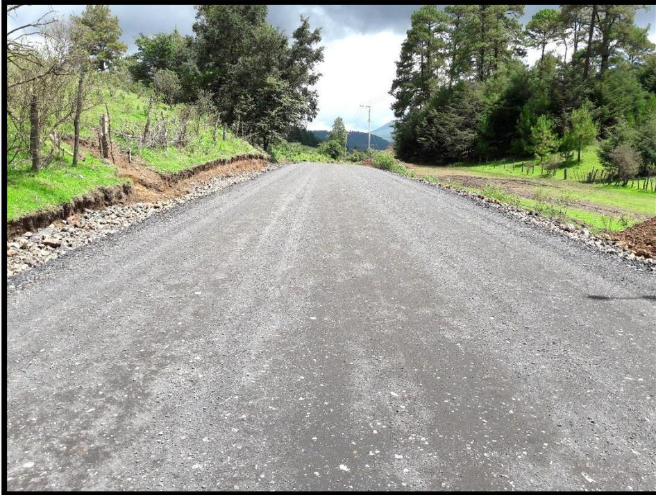
Figura 5.12. Base hidráulica terminada a nivel de proyecto.
