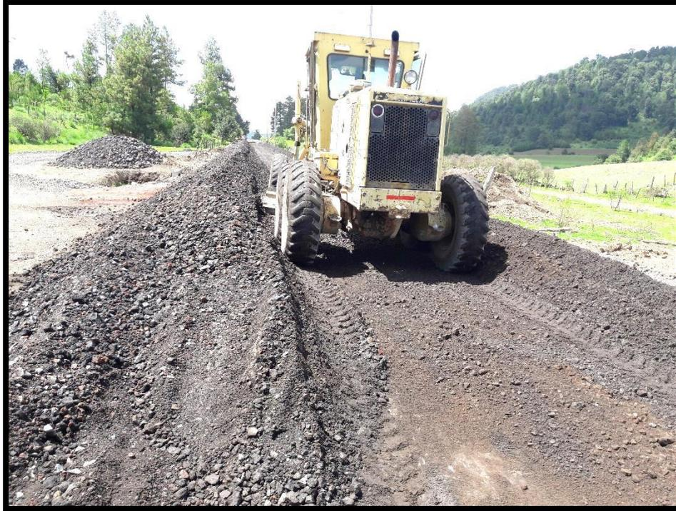
Figura 5.10. Tendido de base hidráulica.
