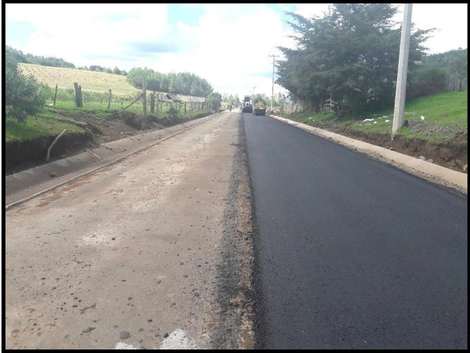
Figura 5.13. Tendido de la carpeta asfáltica.
