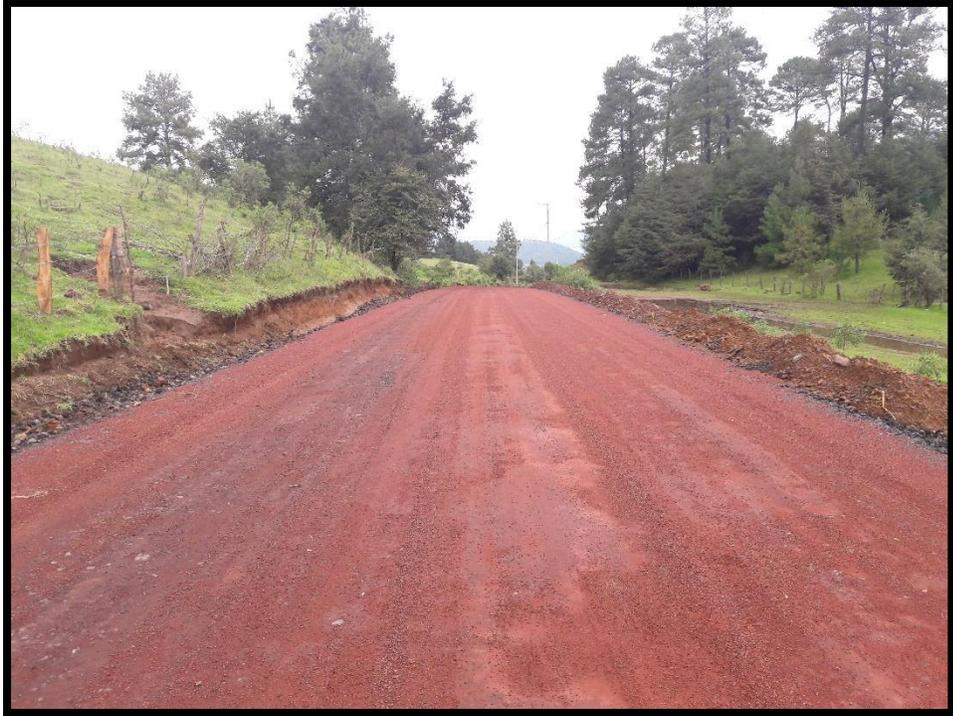
Figura 5.12. Riego de impregnación con poreo.
