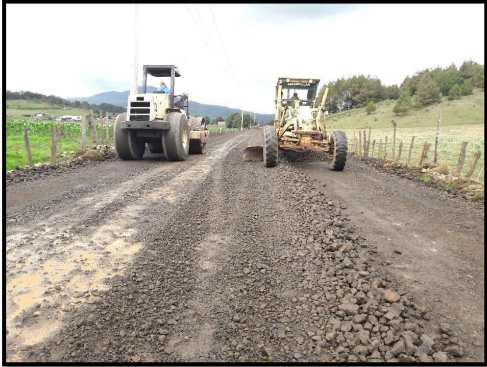
Figura 5.8. Tendido y compactado de subrasante.
