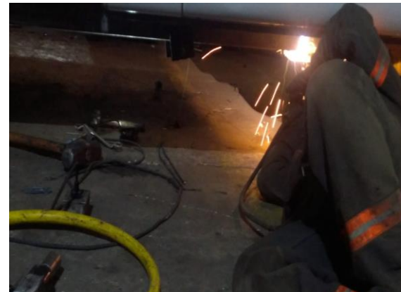
Fotografía 6. Soldadura de la coraza
