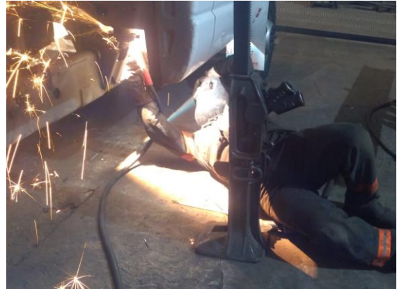
Fotografía 2. Retiro de elementos
