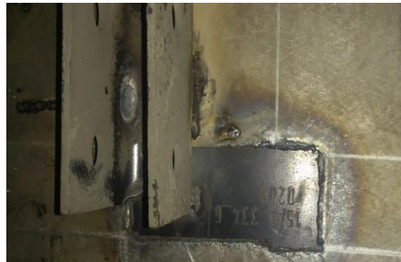
Fotografía 6. Soldadura de la coraza
