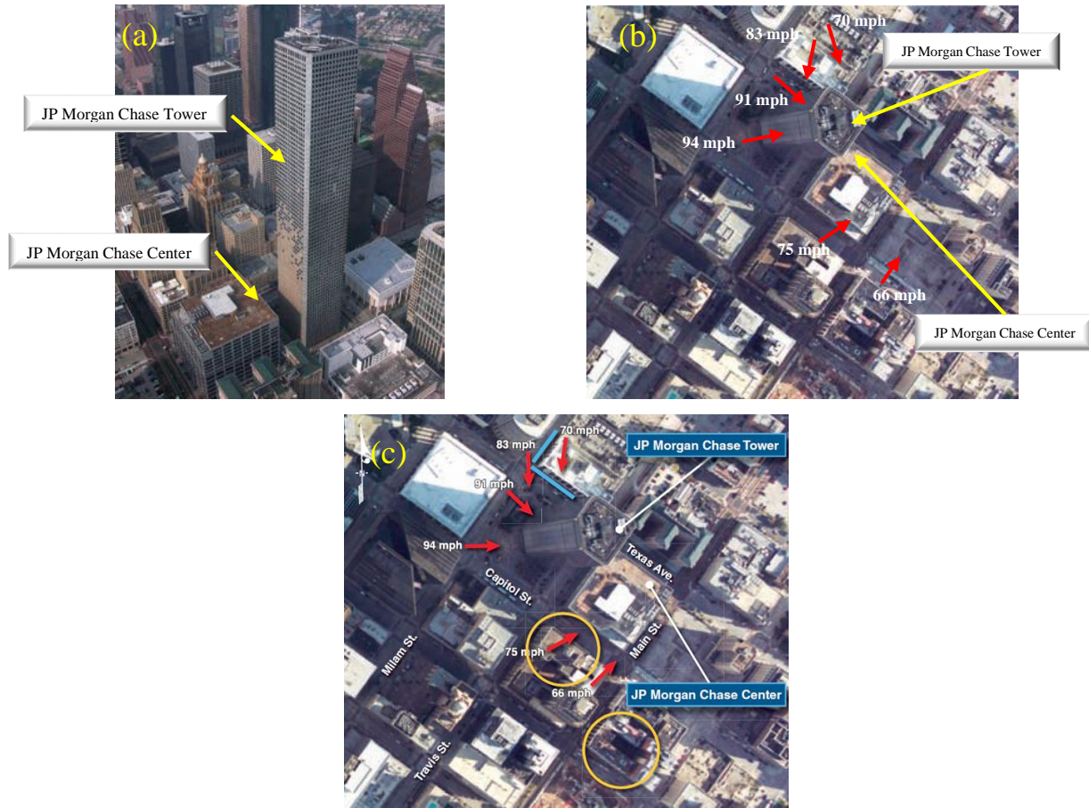
Figura 1.8, a) daño en edificios, b) dirección del viento y c) velocidad del viento, durante el huracán Ike (2005) (FEMA P-757, 2009)
