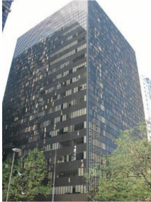
Figura 1.6 Daños en la fachada de cristal durante el huracán Katrina (2005)
