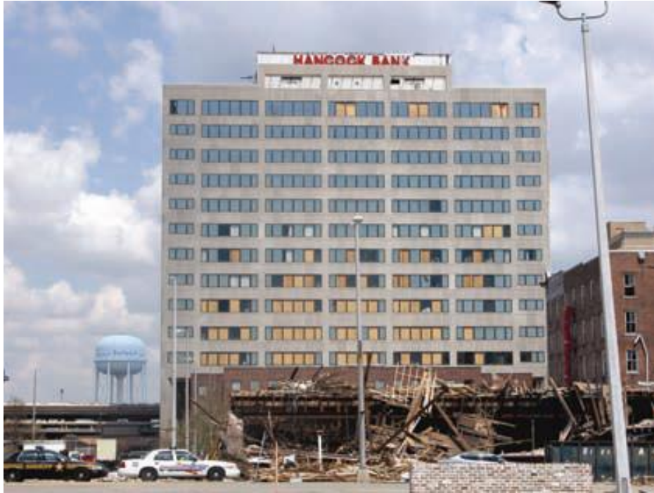
Figura 1.7 Edificio dañado por el huracán Katrina (Hancock Bank)
