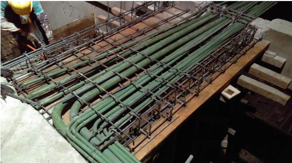
*Figura IV.I.III Instalación eléctrica ahogada en losa*
