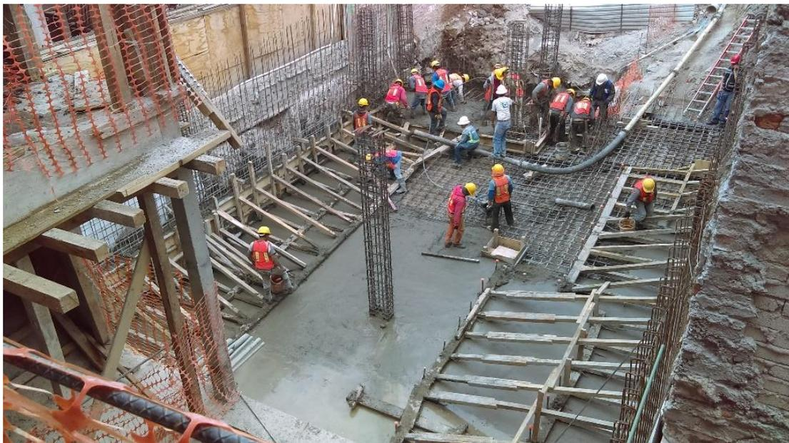
*Figura III.1.II Colado de losa de cimentación etapa 2*
