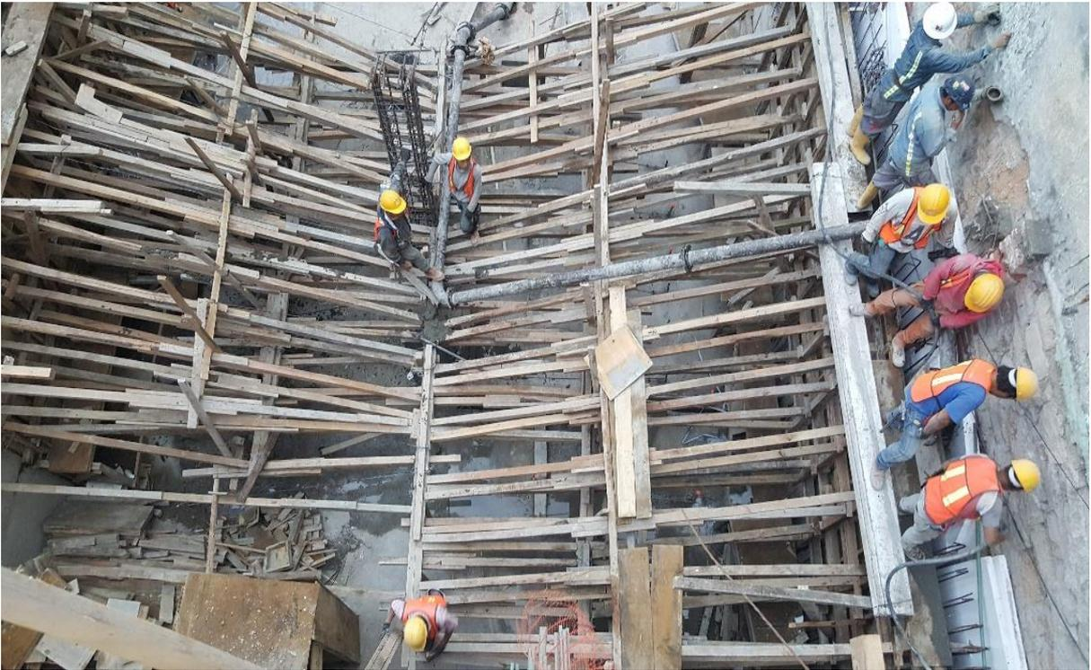
*Figura III.II.III Colado de muro de contención perimetral*
