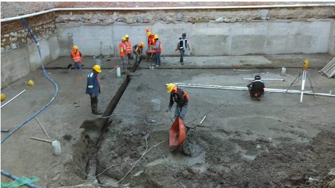
*Figura III.1.1 Cepas para contratrabes de losa de cimentación*
