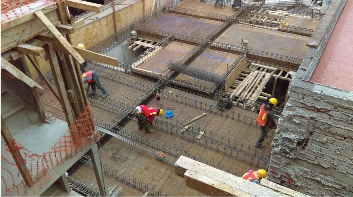
*Figura III.III.III Armado de acero de Losa de nivel*
