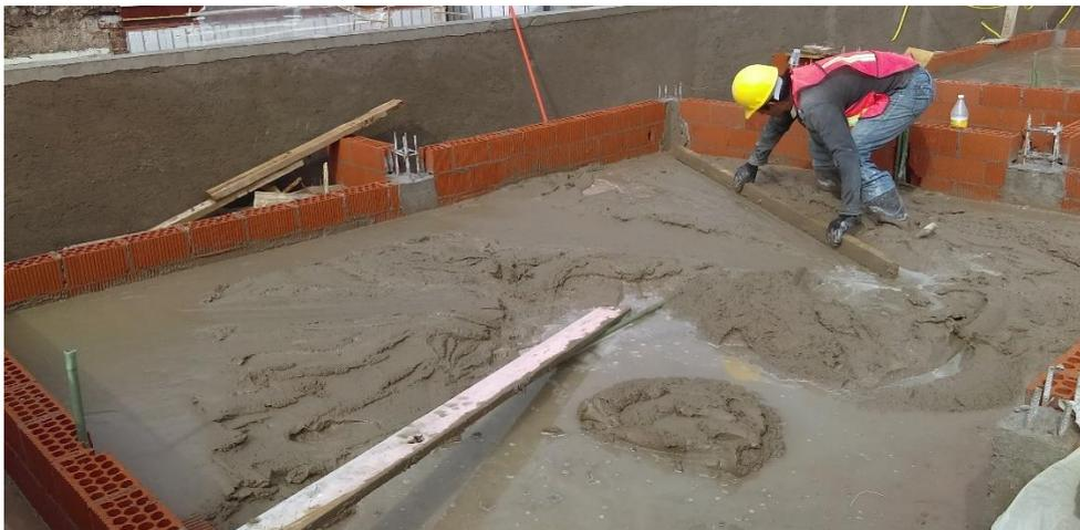
*Figura III.IV.XI Extendido de relleno fluido*
