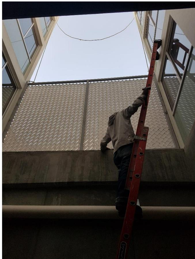
*Figura V.XV Colocación de Mallas de protección*
