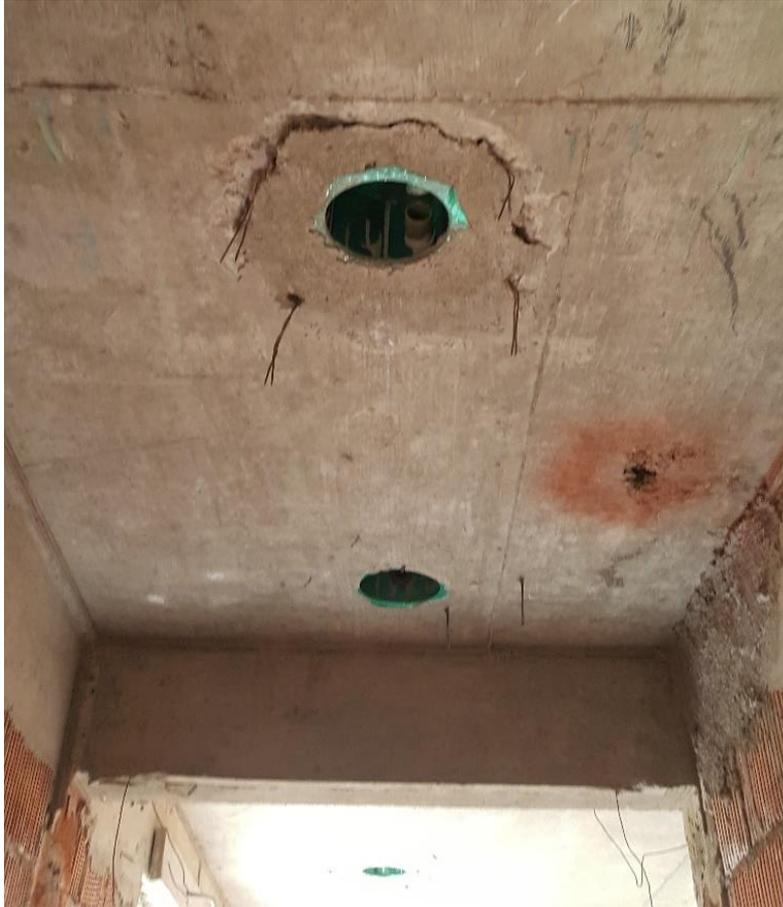
*Figura V.1 Bote integral ahogado en Losa*
