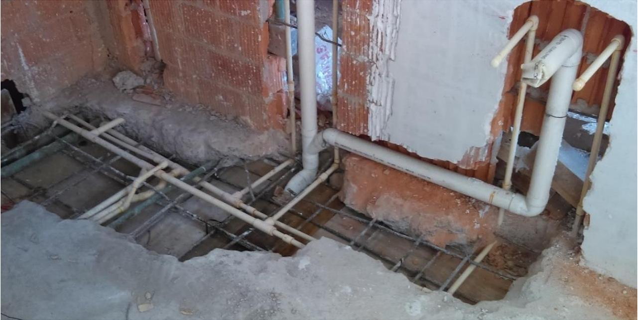
*Figura IV.III.II Instalación hidráulica y sanitaria*
