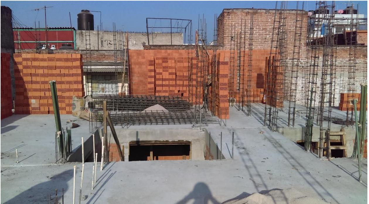
*Figura III.IV.VI Preparación para alzado de muros y castillos de nivel*
