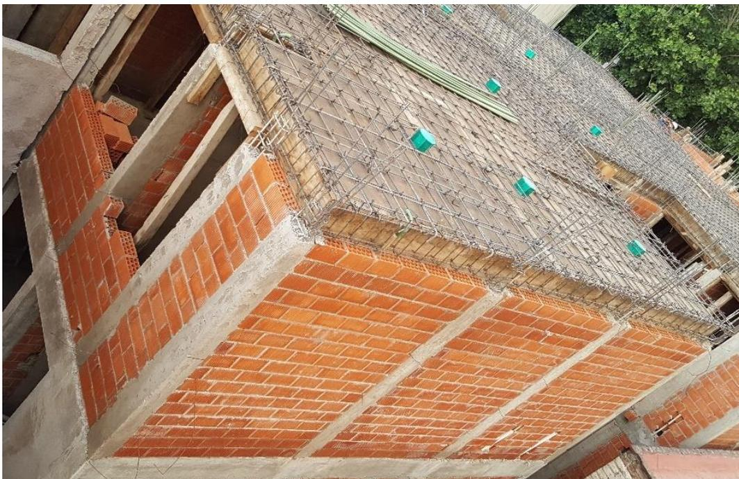
Figura III.IV.V Muros de block y castillos
