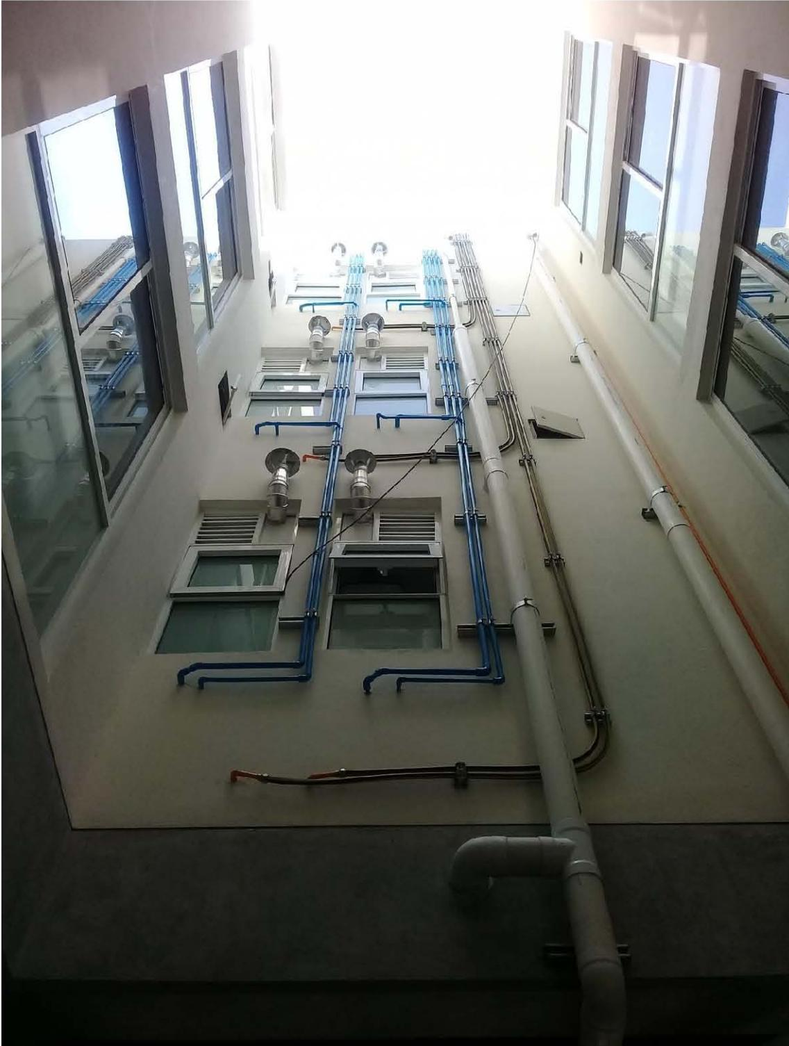
*Figura V.XIV Tubería de agua potable*
