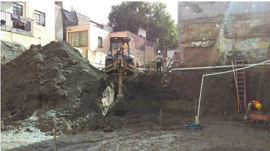
Figura II.II.II Excavación con maquinaria
