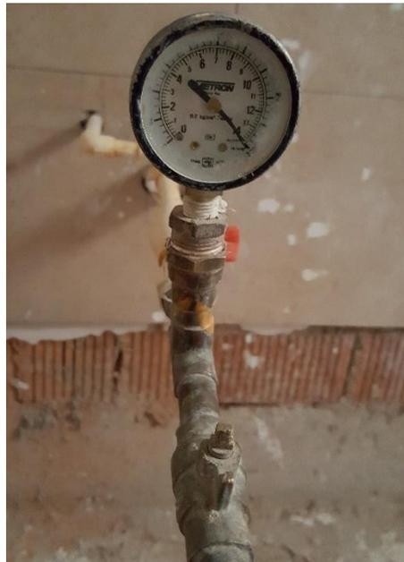
*Figura IV.III.III Barómetro para pruebas hidráulicas*
