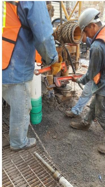
*Figura II.II.IV Perforación de pozos*
