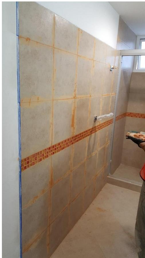
*Figura V.X Junteo de lambrines en baño*
