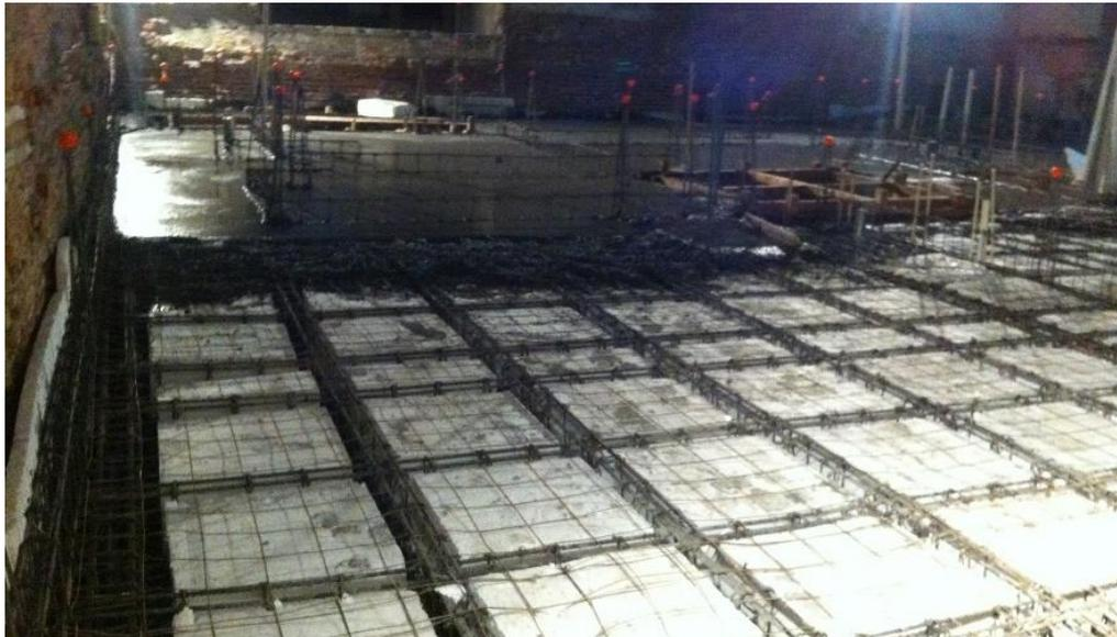
Figura III.III.VI Colado de Losa nervada, aligerada con casetón
