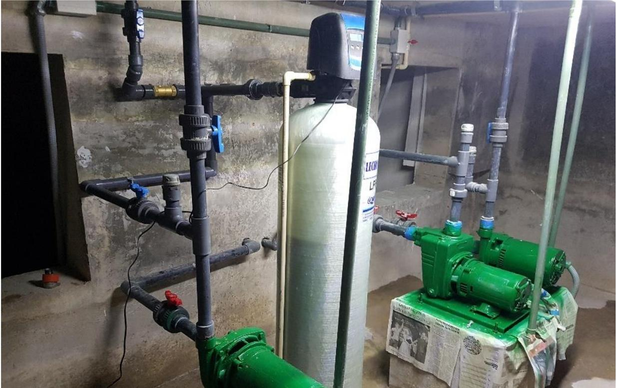
*Figura IV.III.1 Sistema de bombeo y filtrado en cuarto de máquinas*
