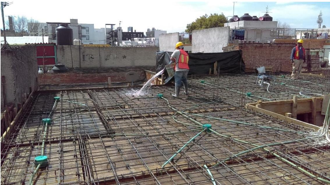
*Figura III.III.VIII Armado de doble parrilla de Losa*
