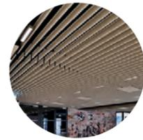
Plafón lineal a base de paneles metálicos colocados verticalmente a 1.00m anclados de la losa de concreto, modelo 100V de la marca Hunter Douglas.
