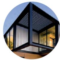
Estructura de acero con primario epóxico E-1030 marca Comex base agua color gris, posterior recubrimiento intumescente FRA-1000 marca Comex base agua como protección contra incendios, acabado final de pintura poliuretano Polyform 11000 color negro.
