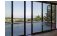
Cancelería de PVC conformada por cuatro marcos color negro mate y una puerta abatible de 90cm. listos para recibir vidrio laminado acústico con espesor de 8mm.
