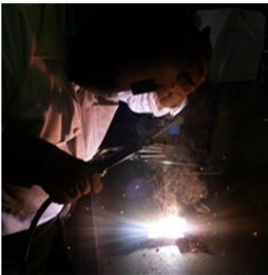
Fig. 20. Aplicación del cordón de soldadura.
