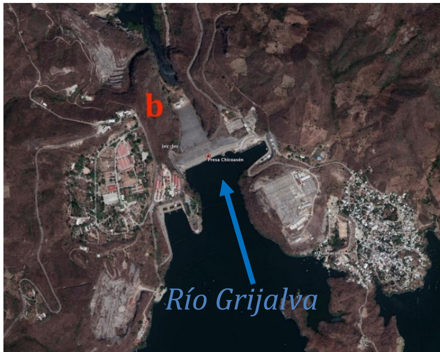
Figura 1. (a) En rojo la ubicación de la presa Hidroeléctrica Chicoasén, mapa base: http://geomapapp.org , (Ryan, y otros, 2009), (b) vista aérea, en azul se indica la dirección de escurrimiento del Río Grijalva (Google & INEGI, 2018)
