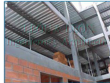
LOSACERO MUROS DE TABIQUE Y PREFABRICADOS
