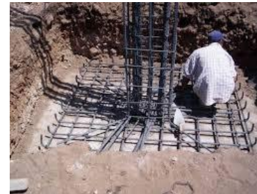
CONST. ZAPATA AISLADA
