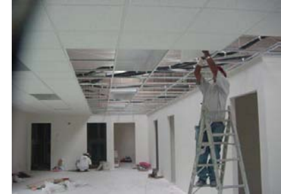
PLAFÓN CON INSTALACIONES
