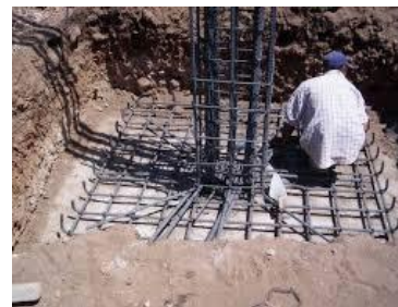
CONST. ZAPATA AISLADA
