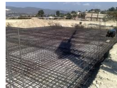
LOSA DE CIMENTACION
