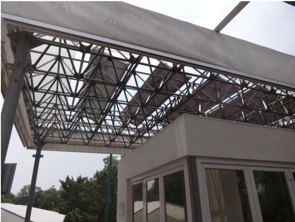
Figura 2-2. Sistema Constructivo de CASA-UNAM
