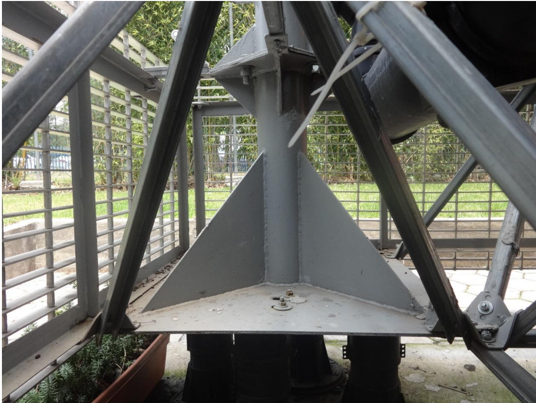
Figura 2-10. Elemento Conector de Columna
