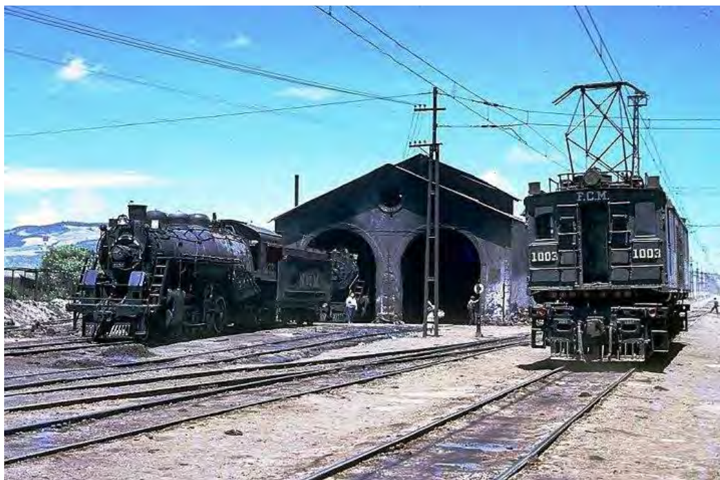
Talleres de reparación en funciones Esperanza. Foto S/A tomada de internet.
