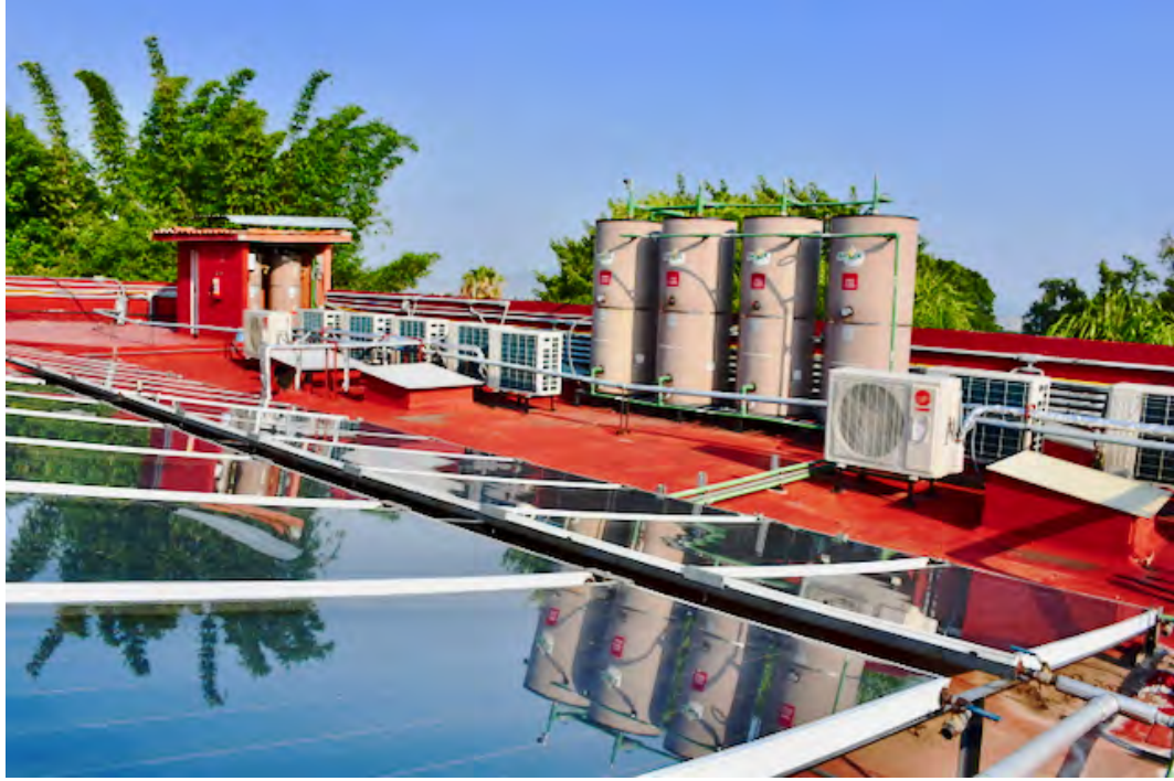
Figura 5.17: Instalación del sistema industrial.
