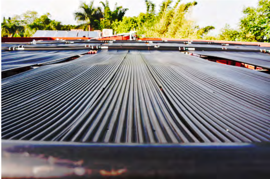
Figura 5.18: Instalación del sistema de de calentamiento para la alberca.
