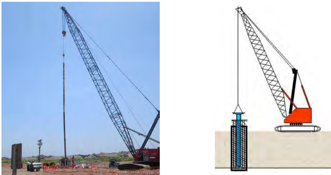
FIGURA 53-54. Colocacion de la tubería tremie. “ICA Dirección de Puertos, agua y minería (2014), Documento 1205 TECII-CON-PTC-001, Rev. 03, p.p. (17).”
