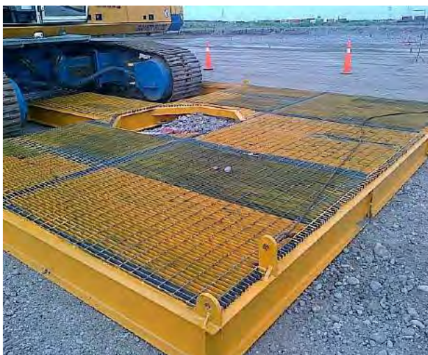
FIGURA 137. Dispositivo de seguridad para plataforma de trabajo del personal. “ICA Dirección de Puertos, agua y minería (2014), Documento 1205 TECII-CON-PTC-001, Rev. 03, p.p. (7).”
